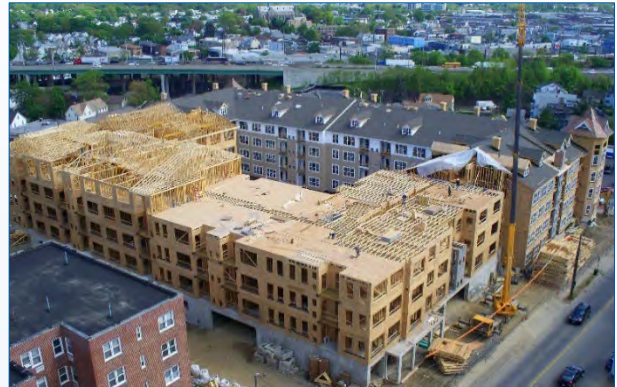
Un édifice en construction au Connecticut.
