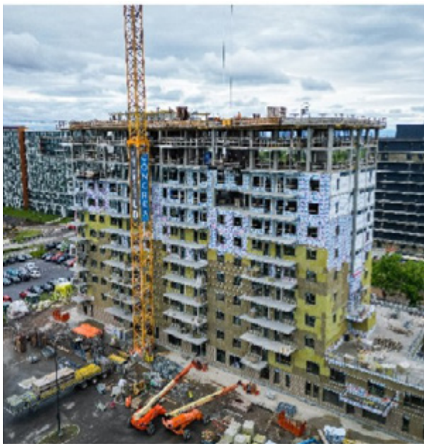
Projet L'Albédo en chantier © Christian Gingras
