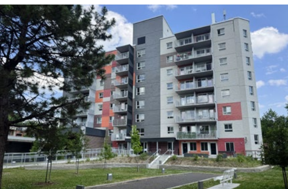
Après la rénovation des Habitations Charlevoix
