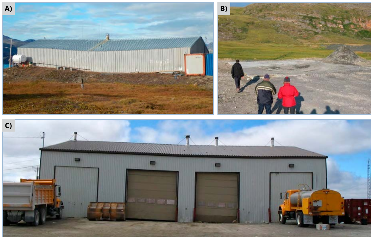
FIGURE 5.53 : DÉFORMATIONS ET DOMMAGES IMPORTANTS CAUSÉS AUX FONDATIONS DE TYPE DALLE SUR SOL À LA SUITE DU TASSEMENT ET DE LA CONSOLIDATION, AU MOMENT DU DÉGEL, D'UN PERGÉLISOL RICHE EN GLACE. A) ENTREPÔT CHAUFFÉ À PANGNIRTUNG AU NUNAVUT. B) DALLE DE L'ANCIENNE CASERNE DE POMPIERS DE LA MUNICIPALITÉ DE SALLUIT AU NUNAVIK. C) ANCIEN GARAGE MUNICIPAL DE LA MUNICIPALITÉ DE TASIUJAQ AU NUNAVIK.
