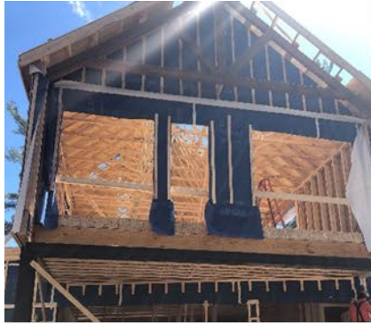
Tri du Bois phase de structure
