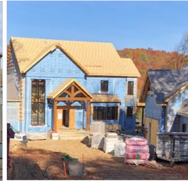
Tri des Agrégats phase de revêtement extérieur
