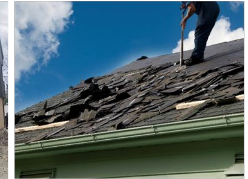
Tri du bardeau phase de déconstruction
