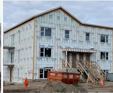
Tri du Gypse phase de pose des murs
