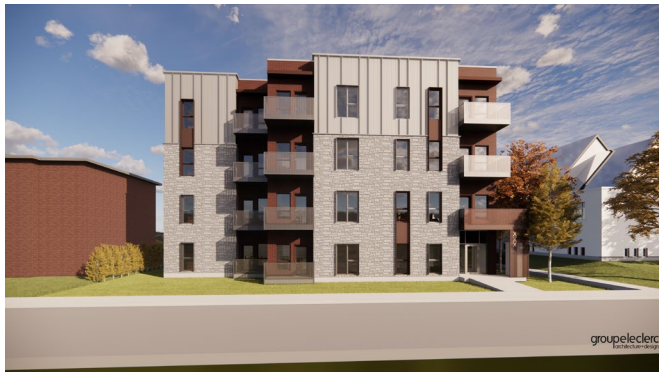
Arch. Pierre Leclerc
