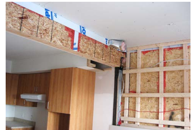
▲ Photo du chantier, jonction du Noyo avec le reste de l'appartement Référence Denis Fortier
