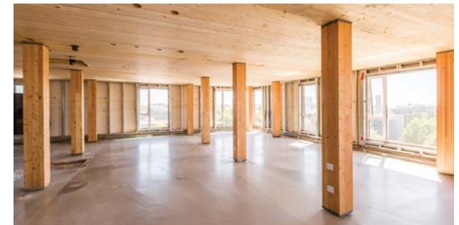
▲ Photo du chantier Référence Naturally wood
