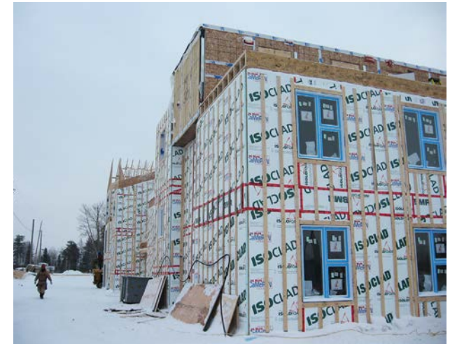
▲ Photo du chantier Référence Denis Fortier
