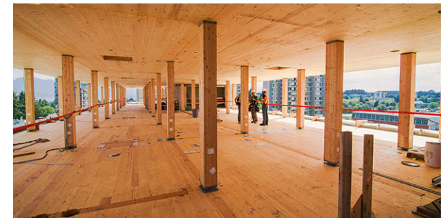
▲ Photo du chantier Référence Naturally wood
