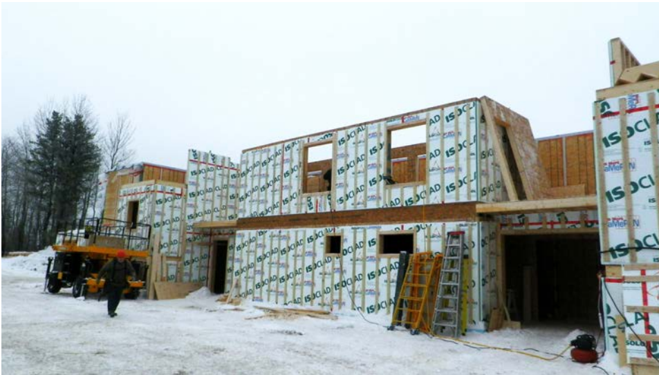
▲ Photo de chantier présentant les murs préfabriqués utilisés pour la construction. Référence Denis Fortier
