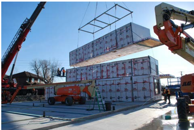
▲ Photo de chantier Référence Bonneville
