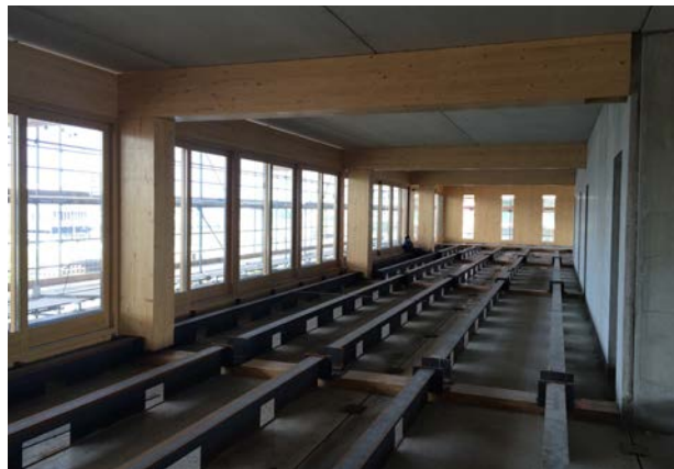
▲ Photo de chantier Référence Lemniskade
