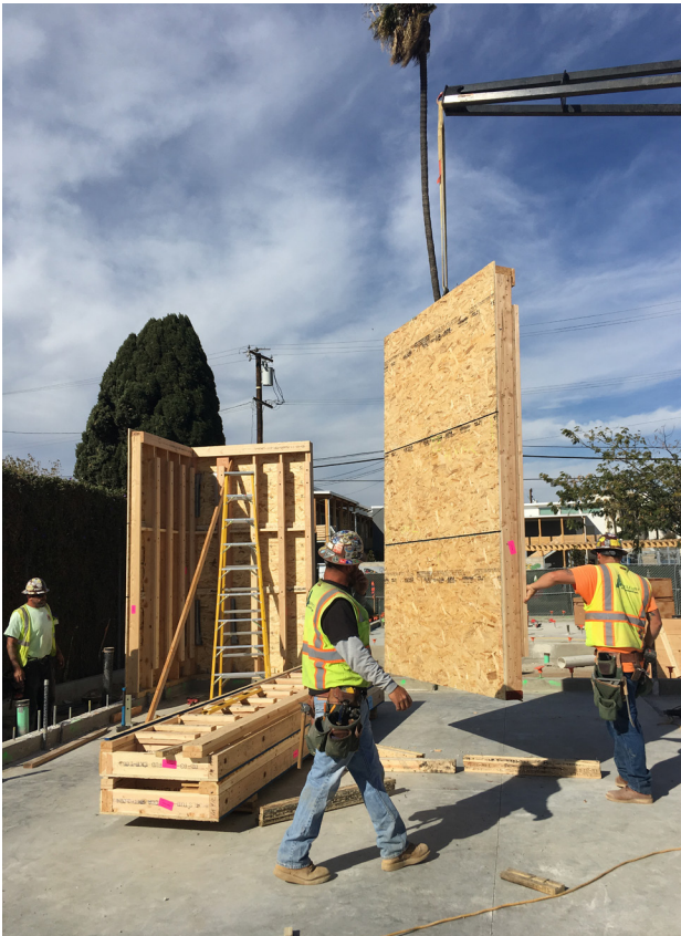
▲ Installation du kit sur le chantier Référence Project Frog
