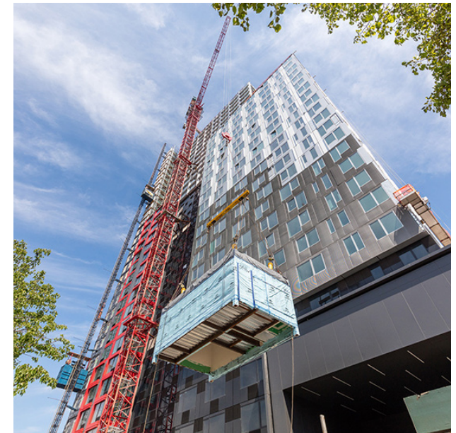
Acheminement d'un module sur le chantier ▲ Source : SHoP Architects
