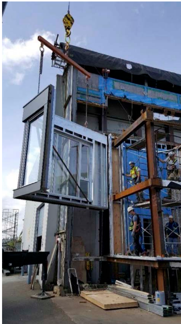
▲ Installation d'un panneau mural Référence Urban One
