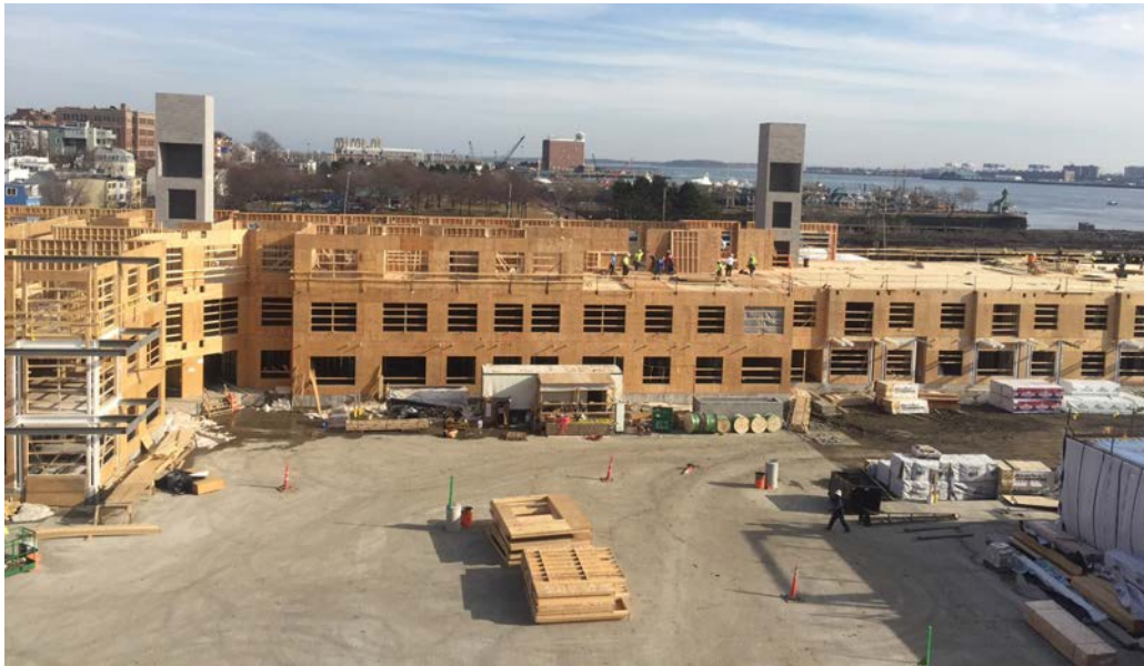
▲ Photo de chantier Référence : American Structure
