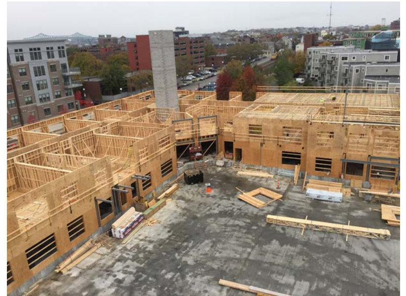
▲ Photo de chantier Référence : American Structure
