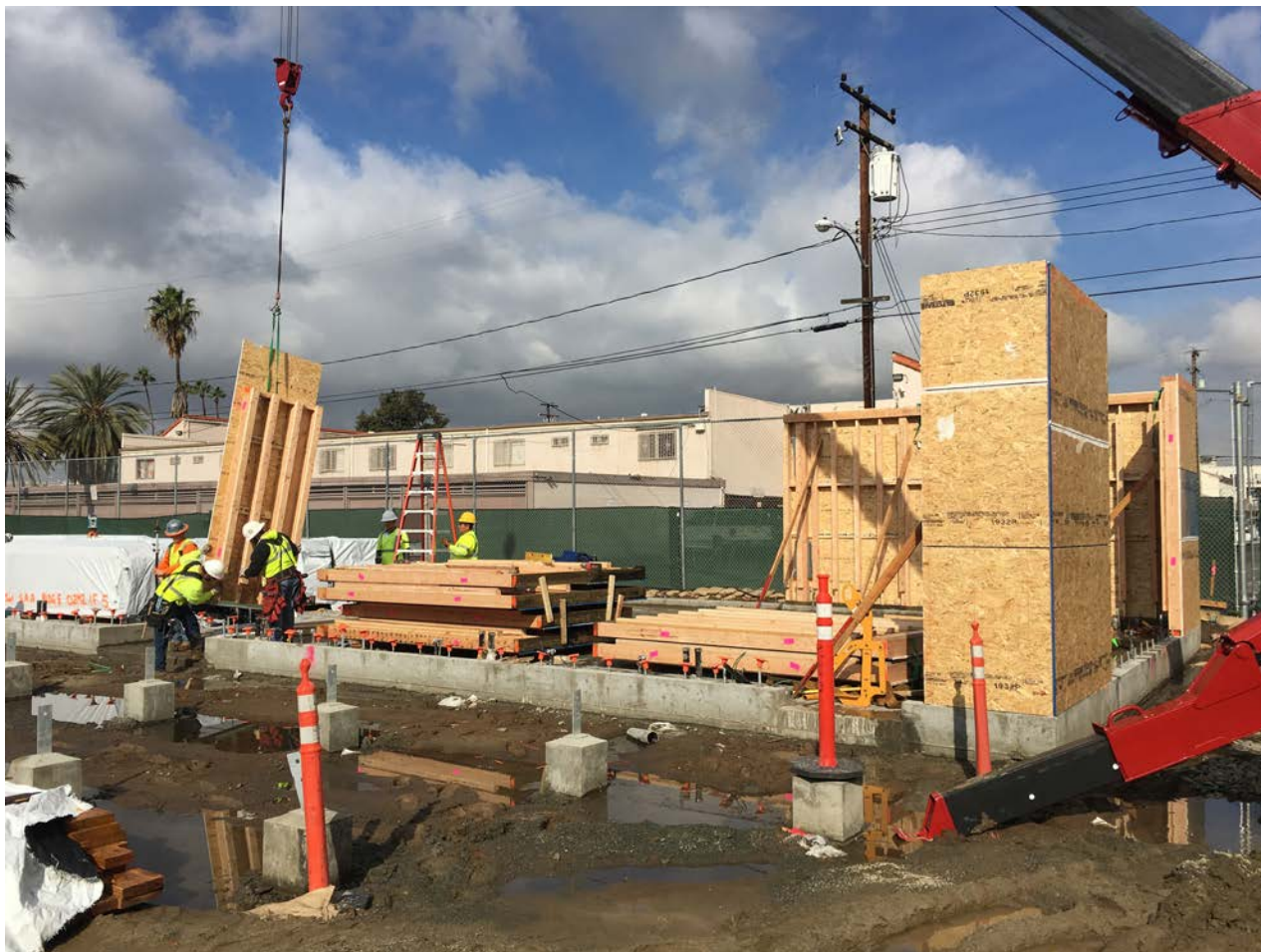
▲ Installation du kit sur le chantier Référence Project Frog
