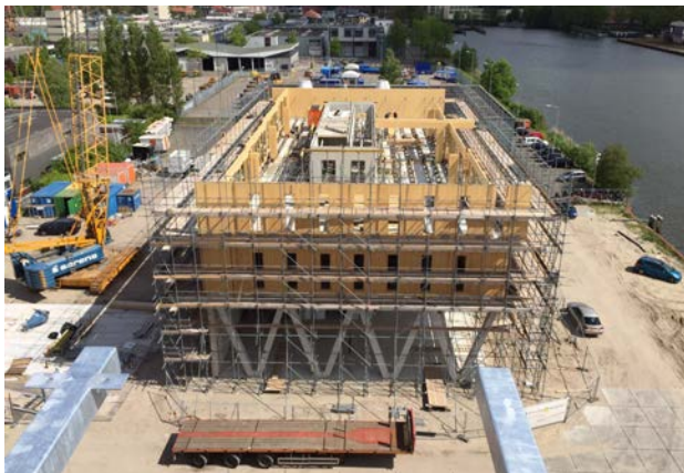
▲ Photo de chantier Référence Lemniskade
