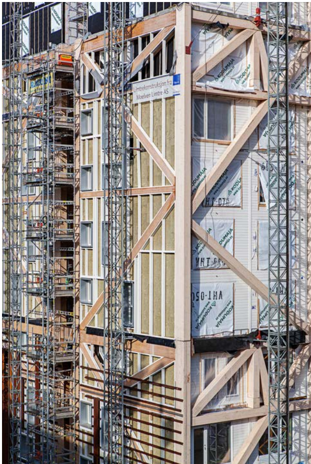
▲ Intégration des modules appartements dans la structure en bois sur le chantier Référence Artec AS
