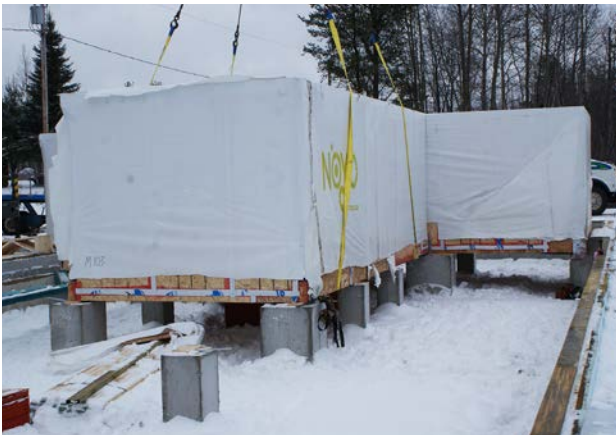
▲ Photo du chantier Référence Denis Fortier
