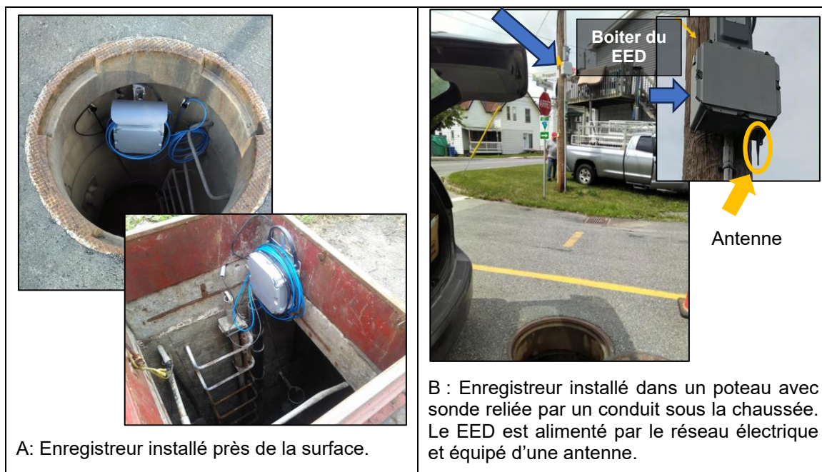
Figure 6-31. Exemples d'installation permettant l'accès à l'enregistreur sans avoir à pénétrer dans l'ouvrage de surverse (espace clos).
