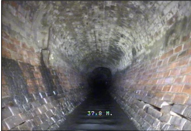
Figure 4-3. Collecteur ovoïde 1 800 mm sur 1 200 mm en brique construit à Montréal en 1865.
