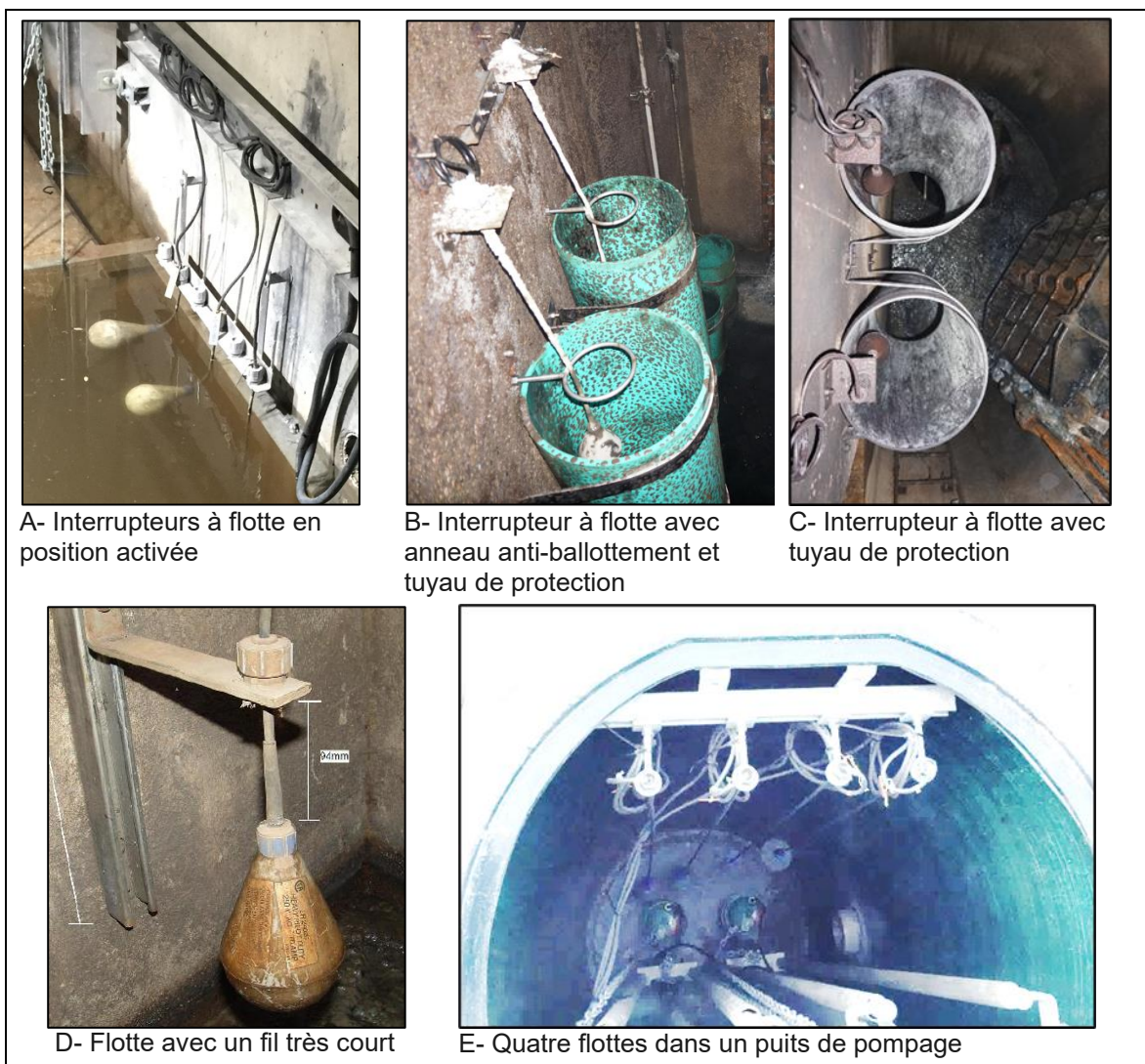
Figure 6-7. Différentes installations d'interrupteurs à flotte
