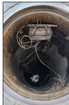
Figure 6-4. Système de suivi électronique des débordements
