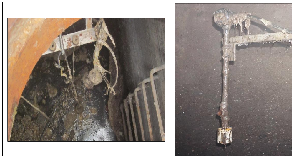
Figure 6-34. Exemples de capteurs très souillés qui sont mal entretenus
