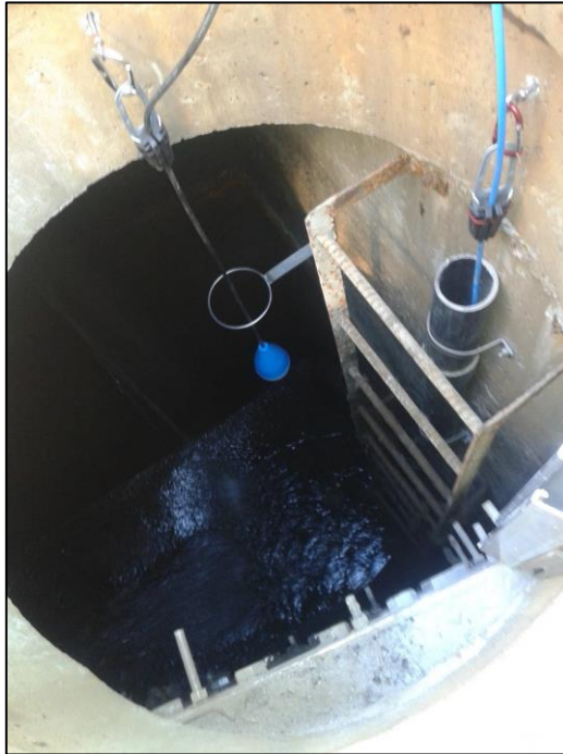
Figure 6-33. Flotte utilisée avec une sonde piézométrique. La flotte est tenue en place par un serre-fil et limitée dans son déplacement par l'anneau anti-ballotement
