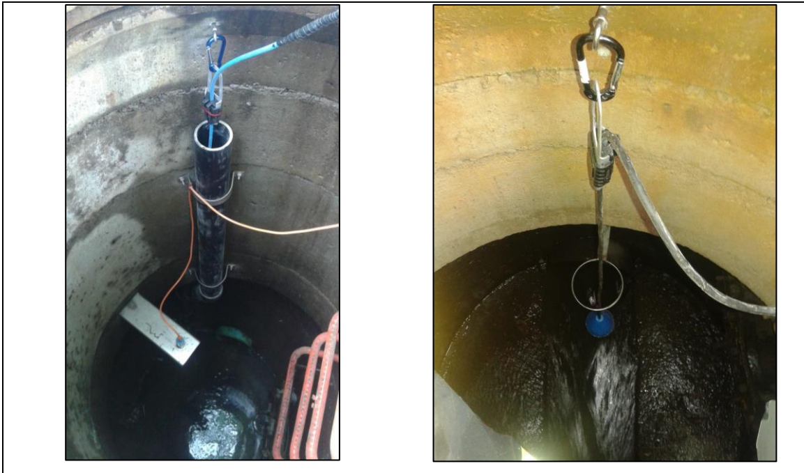
Figure 6-32. Exemples d'utilisation de mousquetons pour faciliter le retrait et la remise en place d'équipement
