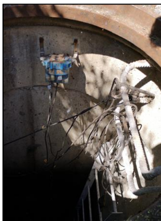
Figure 6-4. Système de suivi électronique des débordements
