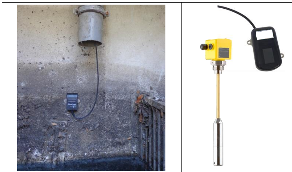
Figure 6-8. Interrupteur capacitif pour la détection de niveau d'eau
