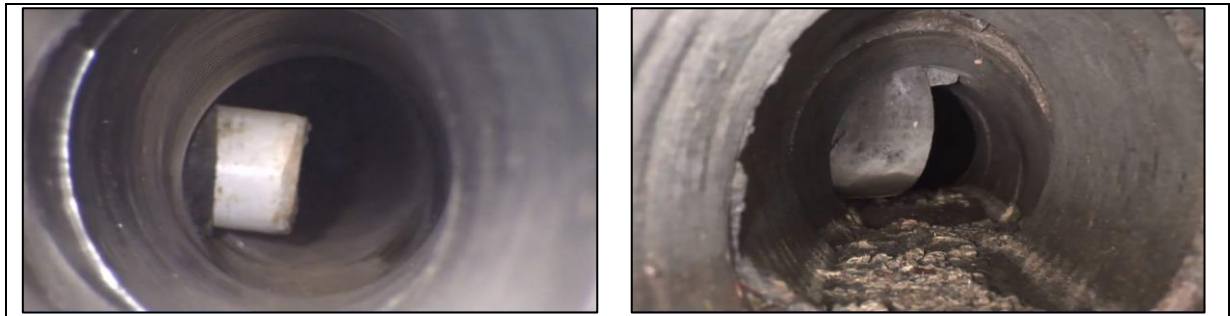
Figure 9-17. Obstructions par des raccords pénétrants
