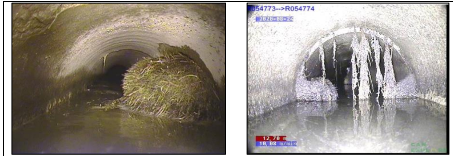
Figure 9-16. Obstructions par des racines
