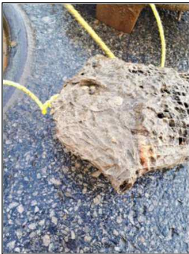
Figure 11-8. Exemple d'utilisation d'une grille au fond d'un regard d'un système de gestion d'eaux pluviales pour détecter la présence d'un raccordement inversé
