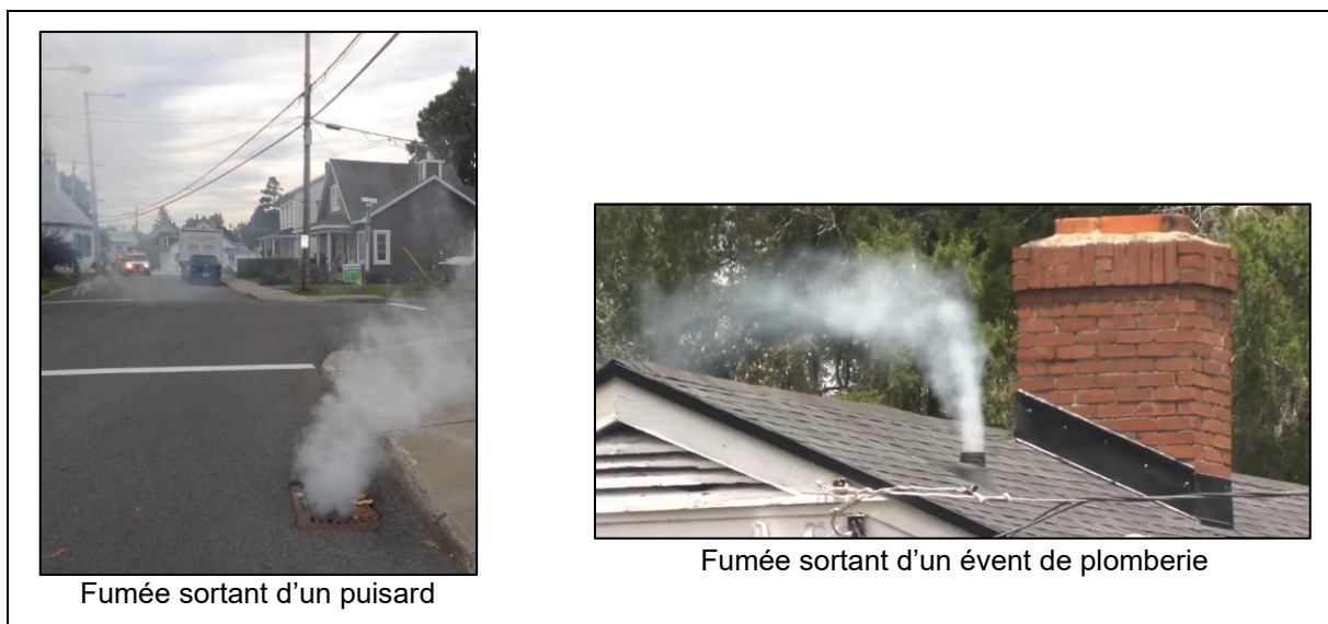
Figure 11-6. Exemples de test à la fumée pour détecter des sources de captage direct.
