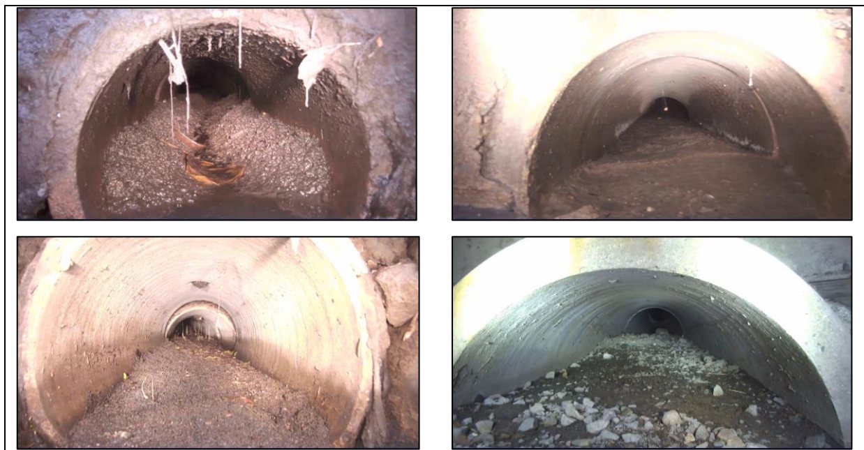
Figure 9-13. Obstructions par du sable et du gravier
