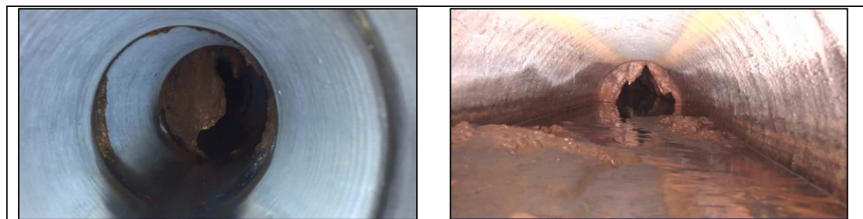
Figure 9-12. Obstructions par des incrustations
