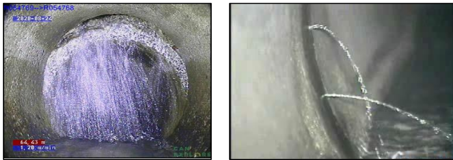
Figure 9-26. Infiltration d'eau dans un système d'égout causée par une condition structurale déficiente
