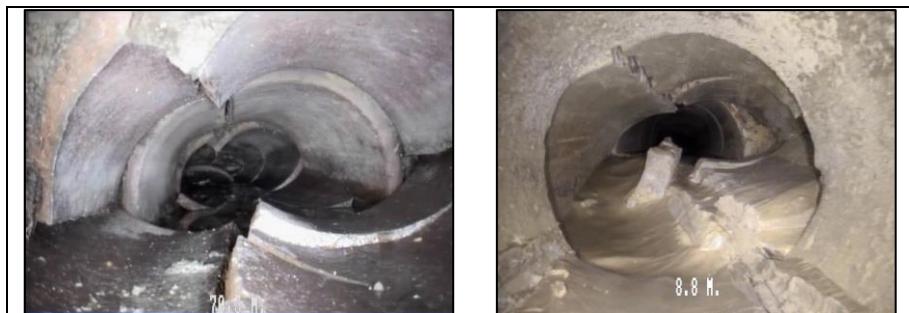
Figure 9-19. Obstruction par l'affaissement ou l'effondrement de conduites
