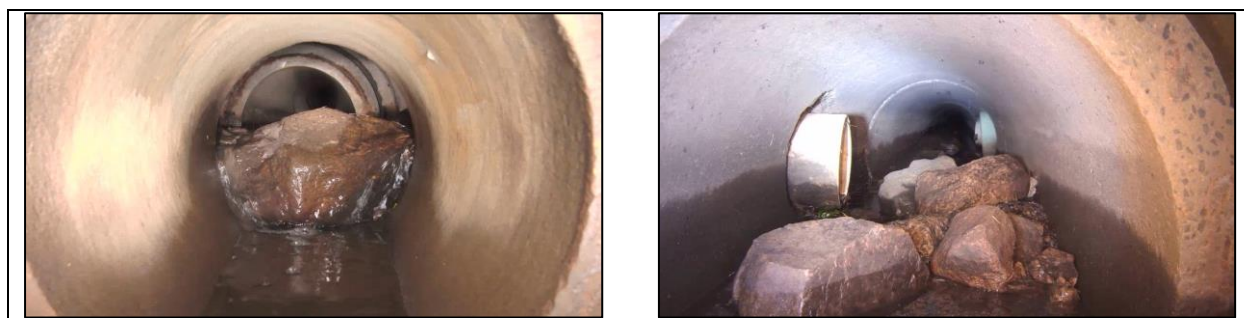
Figure 9-14. Obstructions par des roches
