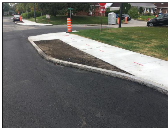
Figure 19-39. Exemple de réaménagement d'une rue où des avancées de trottoir ont été ajoutées, mais avec une bordure pleine n'offrant aucune possibilité de gestion des eaux pluviales.
