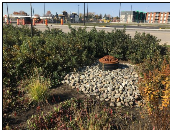
Figure 19-50. Modes de fonctionnement possibles pour évacuer les eaux excédentaires d'une infrastructure végétalisée. À gauche : par débordement. À droite : par trop-plein.
