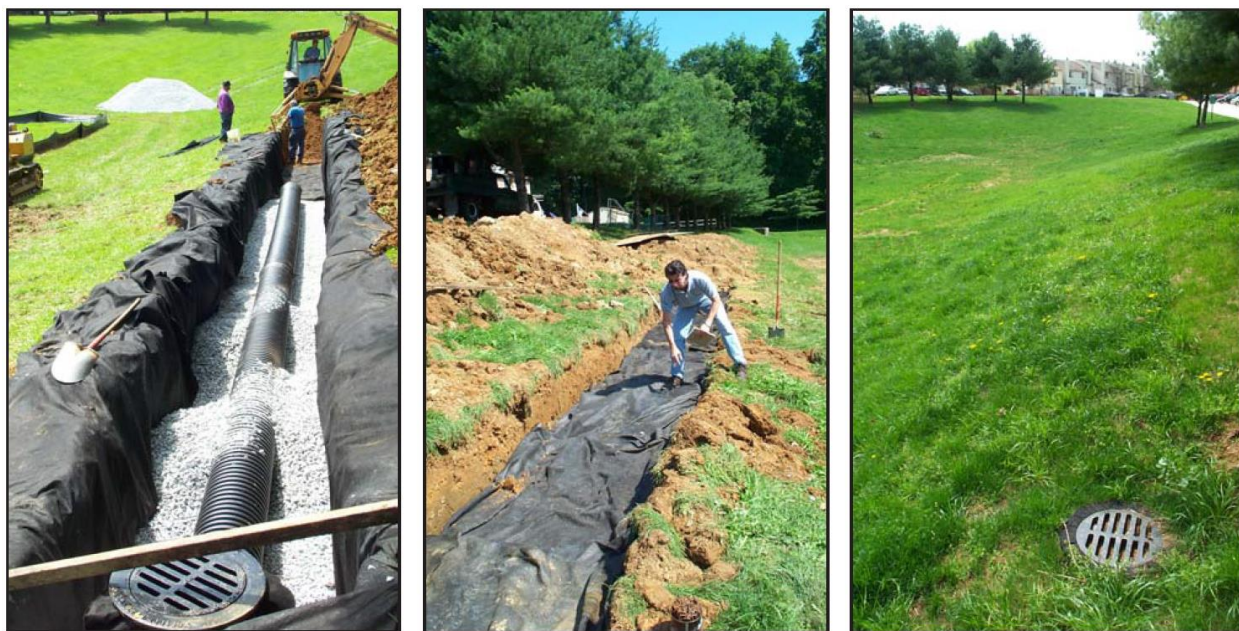
Figure 19-53. Installation d'une conduite perforée
