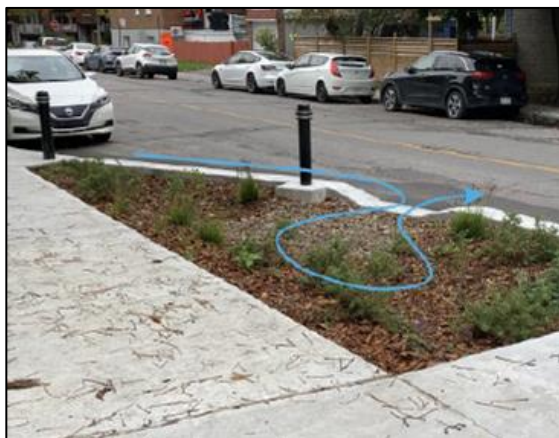
Figure 19-50. Modes de fonctionnement possibles pour évacuer les eaux excédentaires d'une infrastructure végétalisée. À gauche : par débordement. À droite : par trop-plein.
