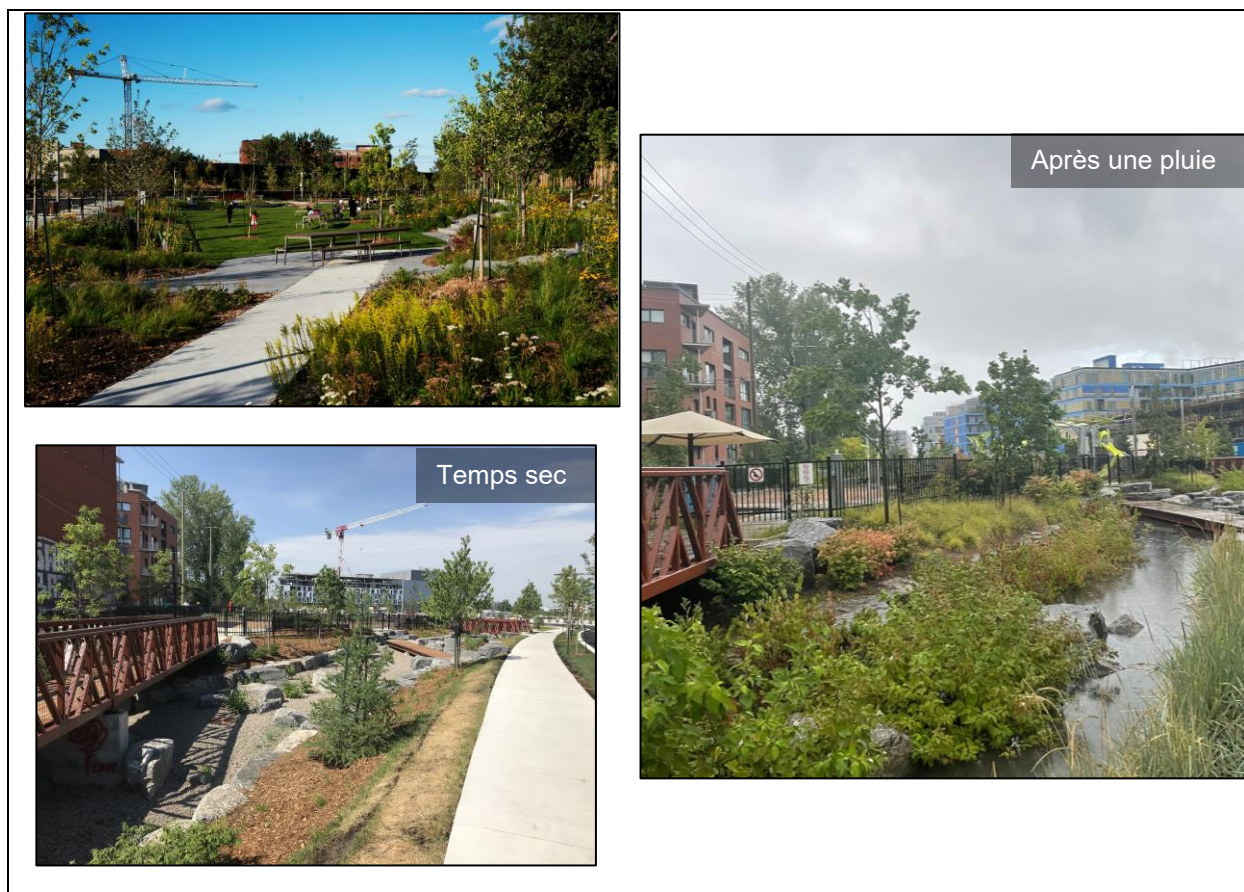
Source : Ville de Montréal Figure 19-48. Espace inondables multifonctionnel à Montréal : parc Pierre-Dansereau dans Outremont (capacité de rétention de 630 m 3 )
