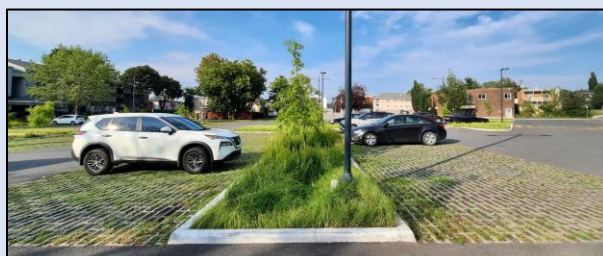
Figure 19-16. Exemple de réhabilitation du stationnement Pierre-Laporte, à Victoriaville, dans un souci de réduire les eaux de ruissellement avec l'ajout d'îlots de biorétention et de cases de stationnement en pavés alvéolés engazonnés. Ce réaménagement a permis une réduction de 75 % des volumes des eaux ruisselées et captées par le système d'égout (Victoriaville, 2022).
