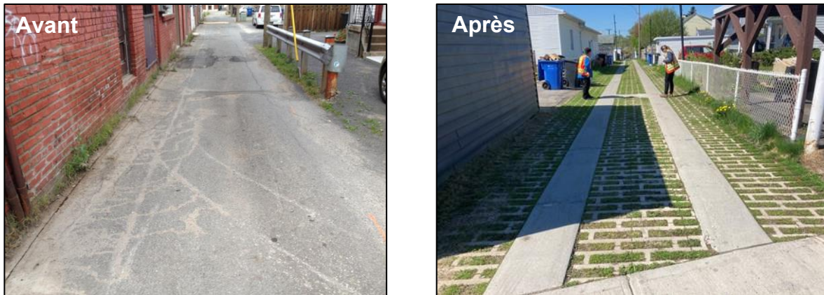
Figure 19-23. Utilisation des pavés alvéolés à Trois-Rivières pour créer des ruelles vertes
