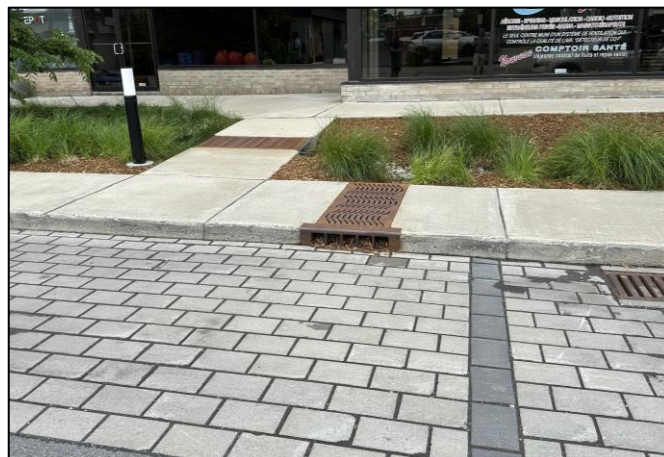
La Ville de Beloeil et le réaménagement de la rue Duvernay avec biorétention et pavés perméables.
