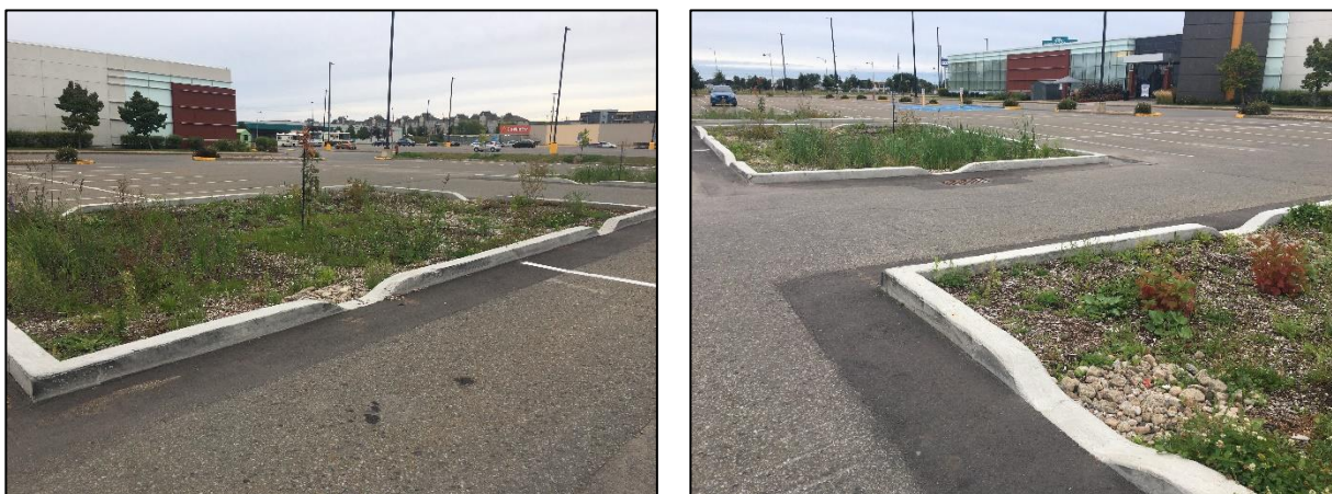
Figure 19-3 Aménagement d'îlots de biorétention dans un stationnement commercial financé par le Programme de verdissement et de déminéralisation de terrains non municipaux de la Ville de Québec.
