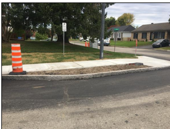
Figure 19-39. Exemple de réaménagement d'une rue où des avancées de trottoir ont été ajoutées, mais avec une bordure pleine n'offrant aucune possibilité de gestion des eaux pluviales.
