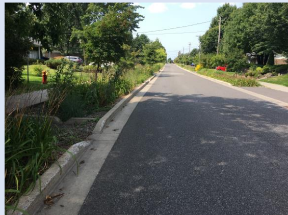
Figure 21-2. Îlots de biorétention aménagés à Granby pour solutionner une problématique en remplacement de la solution initialement envisagée de surdimensionner les conduites
