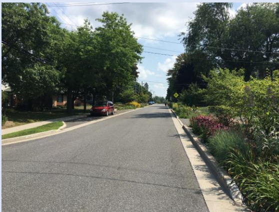
Figure 21-2. Îlots de biorétention aménagés à Granby pour solutionner une problématique en remplacement de la solution initialement envisagée de surdimensionner les conduites
