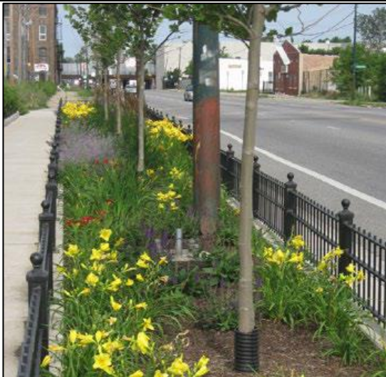
Biorétention sur West Roosevelt Road
