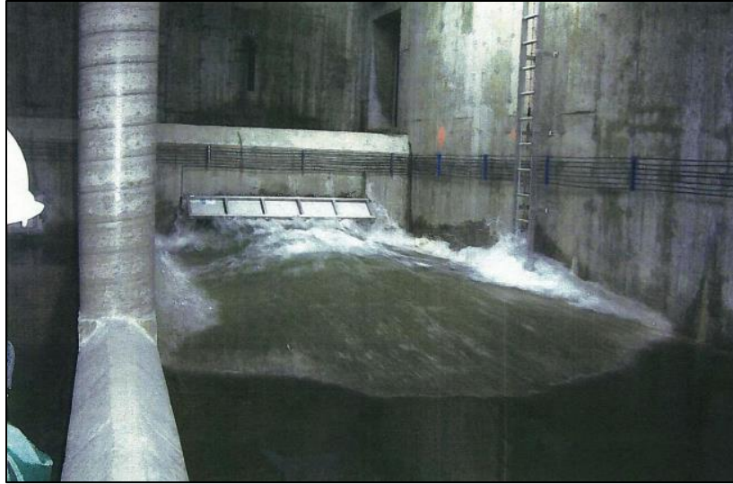
Figure 20-2. Exemple de réservoir avec mécanisme d'autonettoyage
