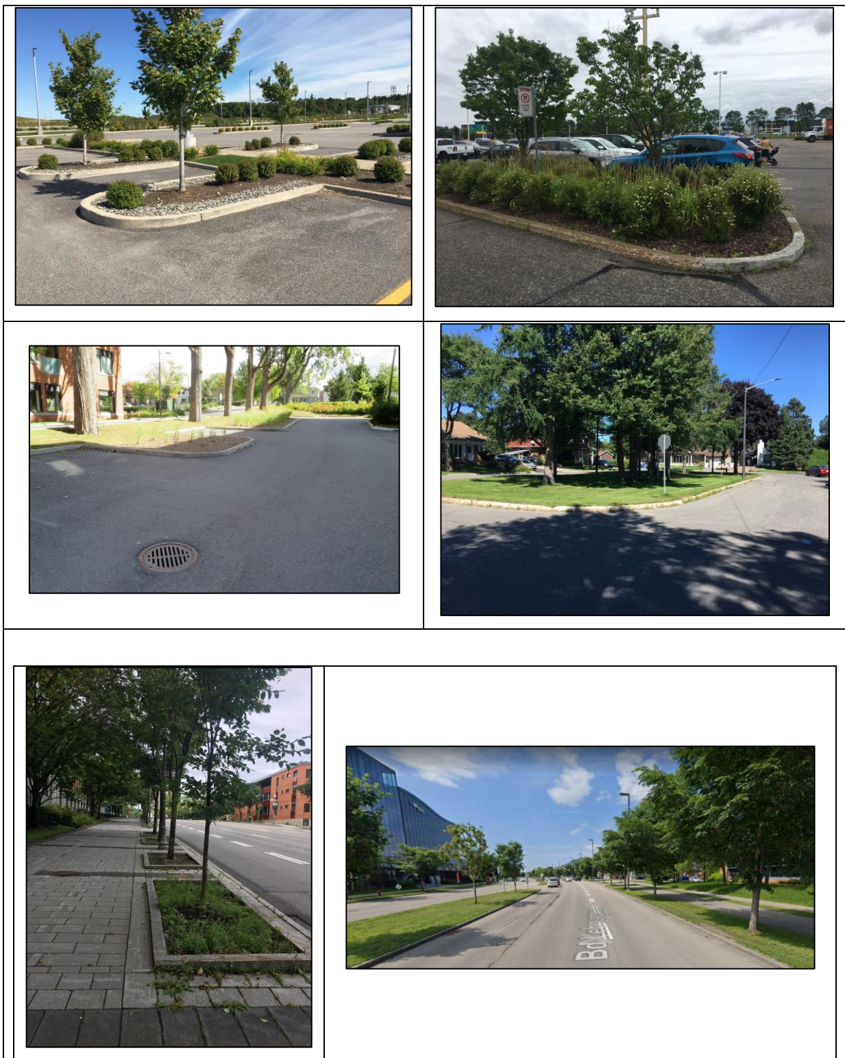
Figure 19-40. Exemple d'îlots verts dans des lieux publics ne permettant pas de capter et d'infiltrer les eaux pluviales en raison de l'installation de bordures continue. La considération des eaux pluviales au moment de la conception aurait pu faire de ces îlots des ouvrages d'infiltration à faibles coûts supplémentaires.
