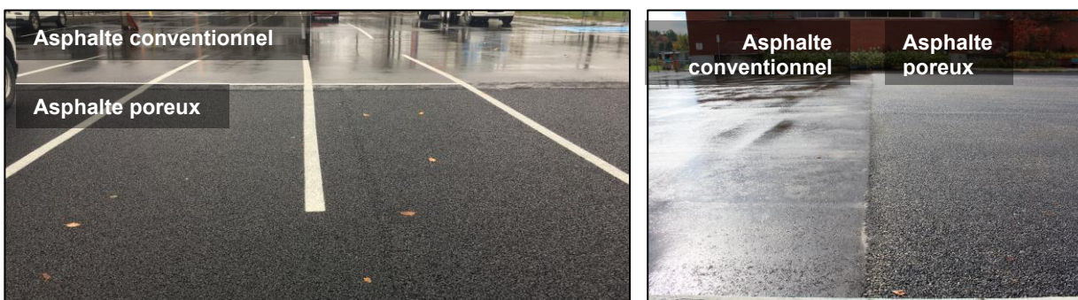
Figure 19-27. Projet pilote réalisé au stationnement du Centre communautaire Paul-Émile-Beaulieu, à Québec, dont le revêtement et la structure sous-jacente ont été remplacés en 2020 par de l'asphalté poreux sur une moitié et de l'asphalté conventionnel sur l'autre moitié. Ce projet a été réalisé grâce à un partenariat entre la Ville de Québec, qui a fourni le site et était responsable de la construction, et le ministère des Transports du Québec (MTQ), qui a développé la formulation de l'enrobé et réalisé la conception. Le site a été instrumenté et fait l'objet d'un suivi par le MTQ et l'Institut national de recherche scientifique pour conduire une étude comparative des comportements structuraux et hydrauliques de chacune des moitiés du stationnement. La vignette montre la différence de texture entre l'asphalté poreux (à gauche) et conventionnel (à droite). Ce projet a fait l'objet d'une présentation au congrès INFRA 2022.
