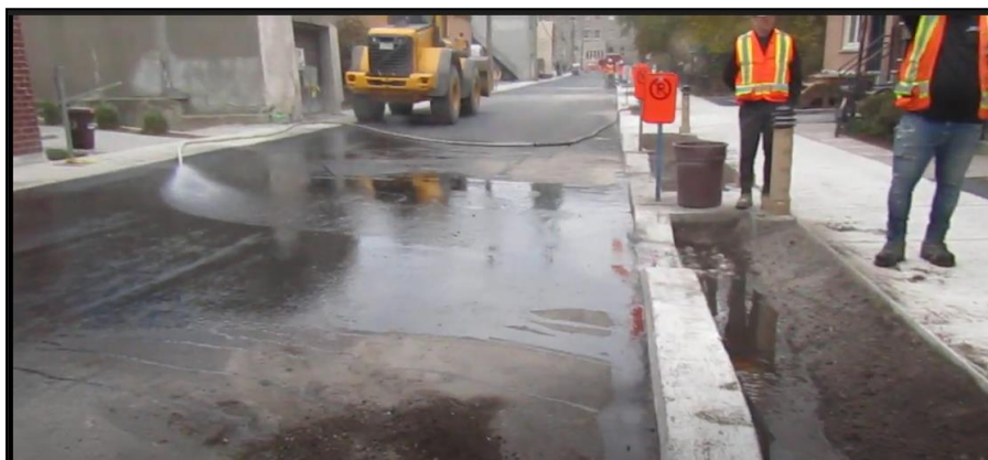
Figure 19-51. Essai de mise en service d'une infrastructure végétalisée avant l'acceptation des travaux pour démontrer que les eaux s'écoulent bien vers celle-ci. Cet essai est exigé par la Ville de Montréal.
