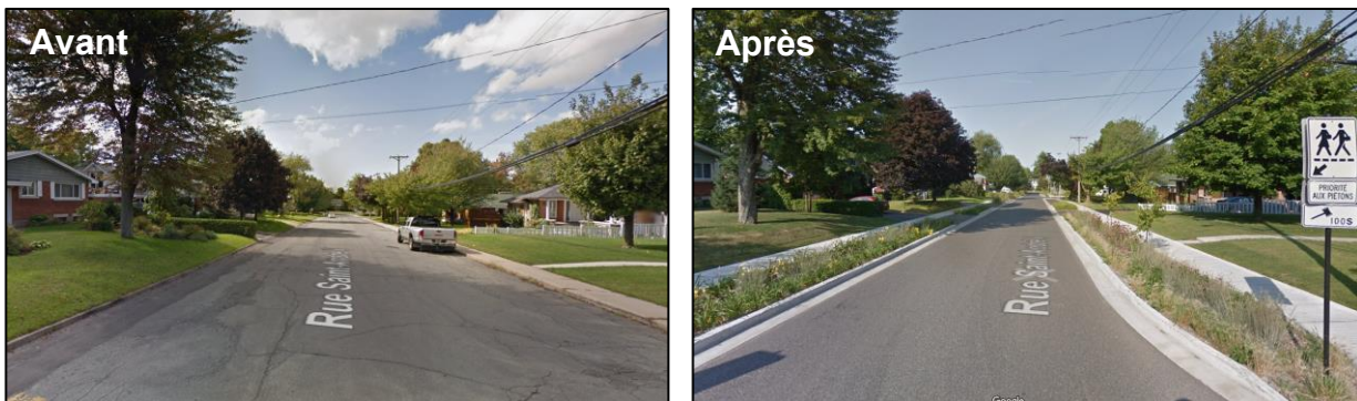
Figure 19-13. Pour régler un problème de refoulement d'égout et de débordement d'eaux usées, la Ville de Granby a modifié la rue Saint-André Est sur une longueur de 1 130 m. La largeur de la rue a été réduite de 12 m à 7 m (des espaces de stationnement ont été conservés à certains endroits où la largeur de la rue atteint 9,7 m) et des îlots de biorétention ont été installés de part et d'autre de la chaussée dans l'espace récupéré. Cette solution a été réalisée en 2013 au coût de 2,35 millions de dollars, une économie de 1,35 million comparativement à la solution initialement envisagée qui était axée sur le stockage des eaux dans des conduites surdimensionnées au coût estimé de 3,7 millions de dollars. Cette solution a aussi permis de réduire la vitesse de circulation à proximité d'une école et d'accroître le verdissement de la ville.
