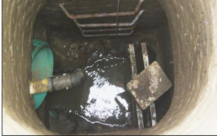
**Figure 9-28.** Exemple de problème d'exploitation d'une municipalité du Québec. Un repère visuel (carré de styromousse blanc) de grandes dimensions a été installé pour suivre les débordements dans la conduite de trop-plein, mais il s'est déplacé dans la conduite d'égout principale et l'a ainsi obstruée. Cette situation a généré un débordement continu pendant une semaine avant qu'il ne soit détecté par la municipalité.
