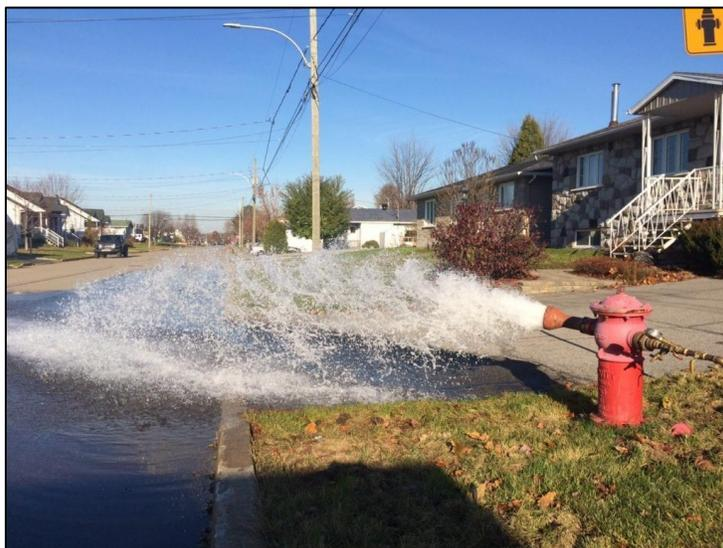
**Figure 9-10.** Exemple d'une opération de rinçage d'aqueduc. S'il est mal planifié (p. ex., ouverture de plusieurs poteaux d'incendie en même temps, rinçage réalisé en contexte de pluie ou en période de pointe de rejet d'eaux usées), le rinçage peut provoquer des débordements.
