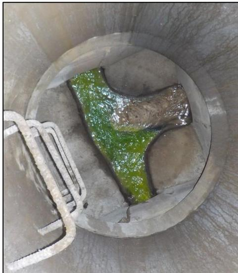
**Figure 11-4.** Exemple d'utilisation d'un colorant vert pour détecter dans un regard d'un système de gestion d'eaux pluviales la présence d'un raccordement inversé
