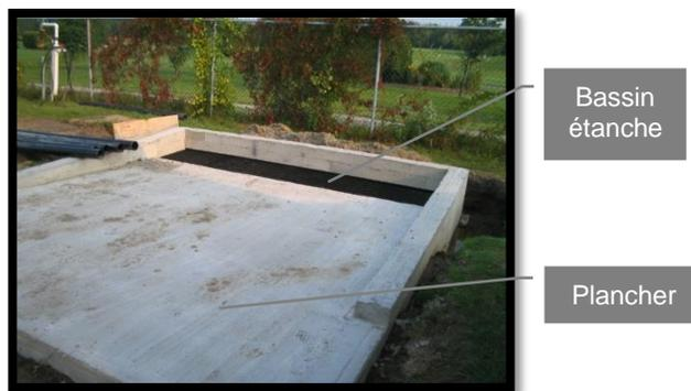
**Figure 2.3 Aménagement comprenant un plancher et un bassin de rétention**
