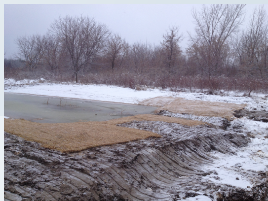
Paillis biodégradable installé après des travaux – une mesure convenable pour protéger les surfaces © Lyne Bouthillier
