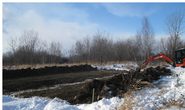
Mise en andains d'une couche superficielle de terre © Lyne Bouthillier
