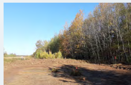
Utilisation de la terre végétale mise en andains pour la finition avant l'ensemencement végétal © Lyne Bouthillier
