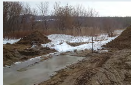
Mise en andains du sol superficiel pour réutilisation comme couche de finition © Lyne Bouthillier
