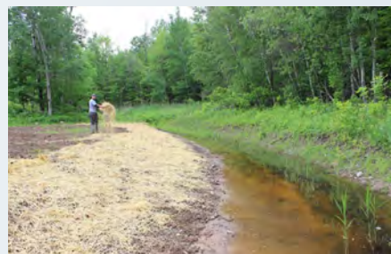
Recouvrement des semences en pentes douces avec de la paille © Lyne Bouthillier
