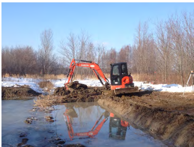
Pelle mécanique de faible poids équipée de chenilles pour le travail en milieu sensible © Lyne Bouthillier
