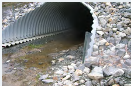
Ailes dépassant le pied du remblai © Lyne Bouthillier
