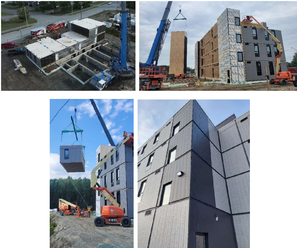
Figure 14 Érection des bâtiments
