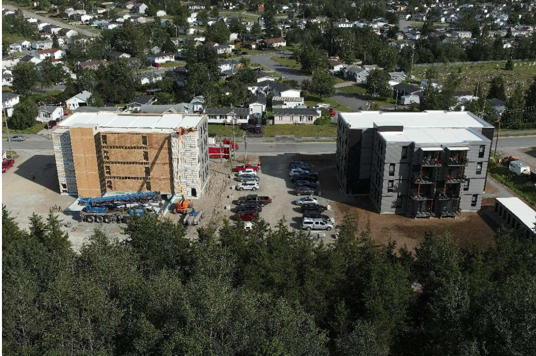
Figure 12 Vue aérienne des Phases 1 et 2 à partir du drone pendant l'installation de la Phase 2
