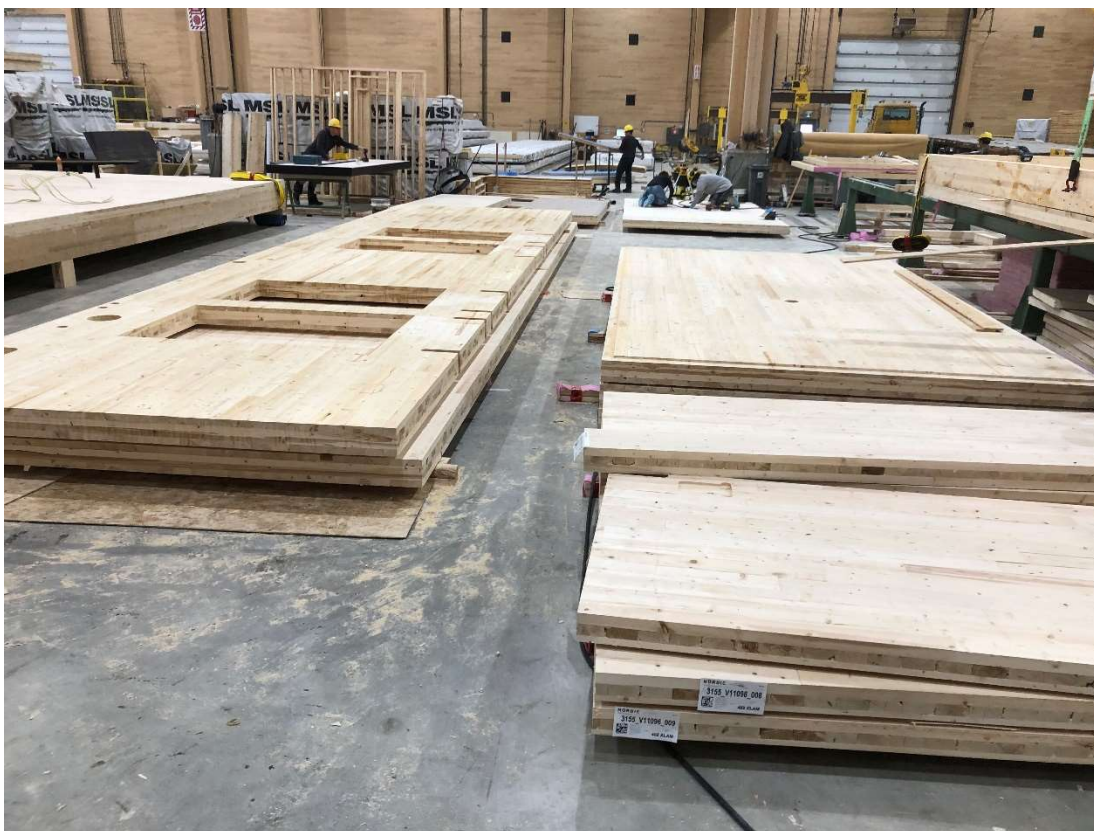
Figure 7 Empilement de panneaux avant les opérations d'assemblage des modules
