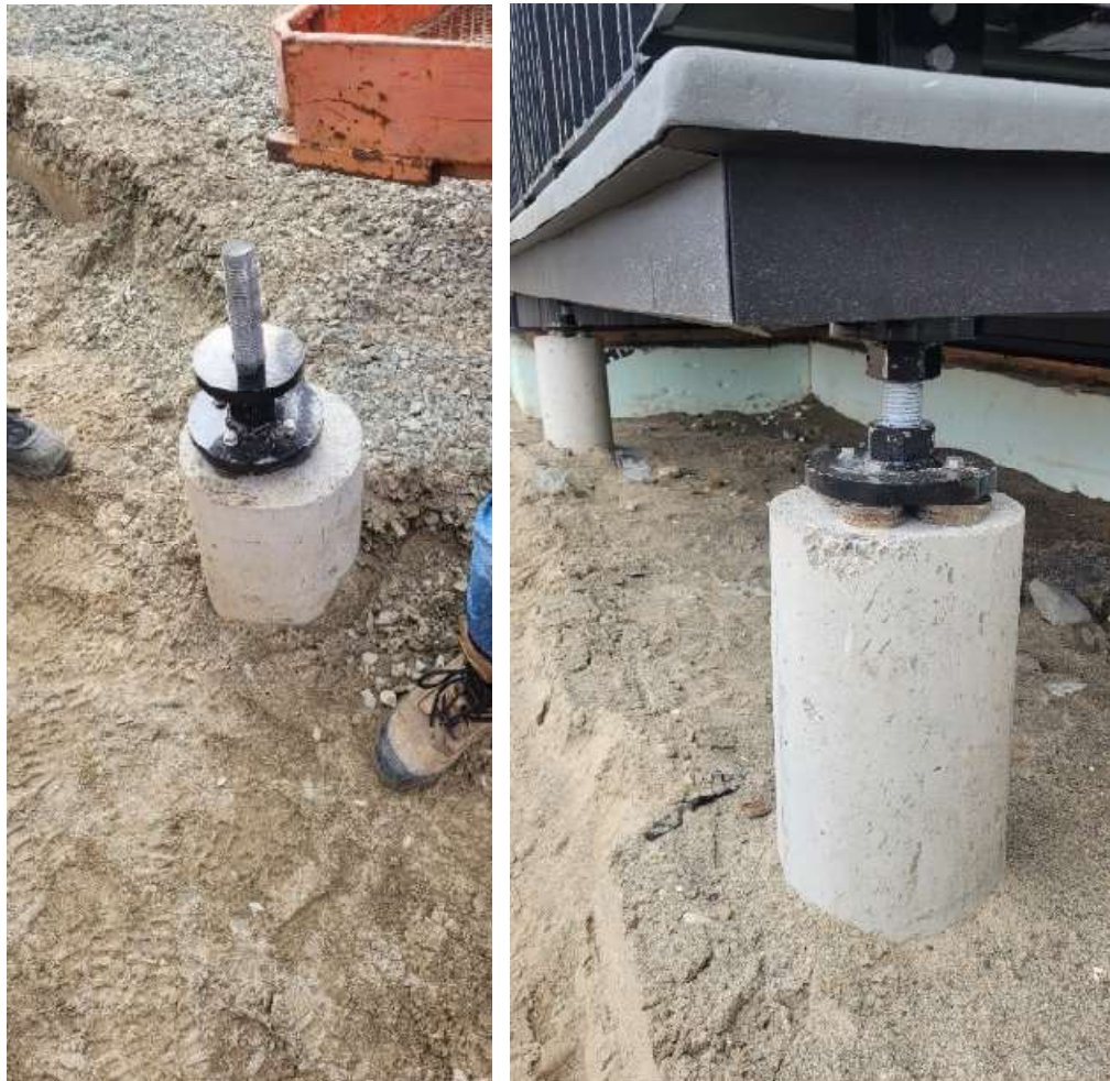
Figure 13 Installation des pieux pour les balcons
