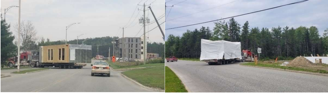
Figure 11 Transport des modules vers le chantier
