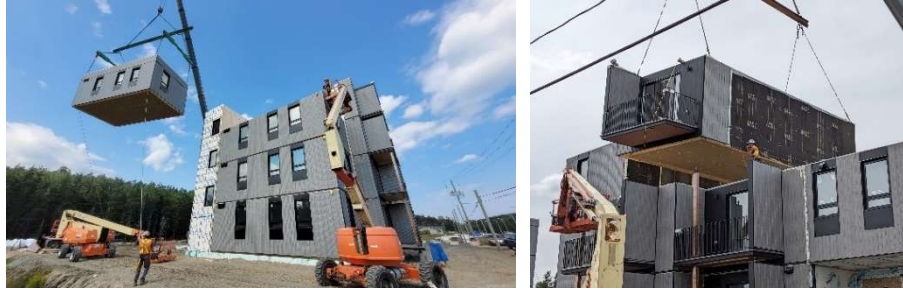
Érection de modules
