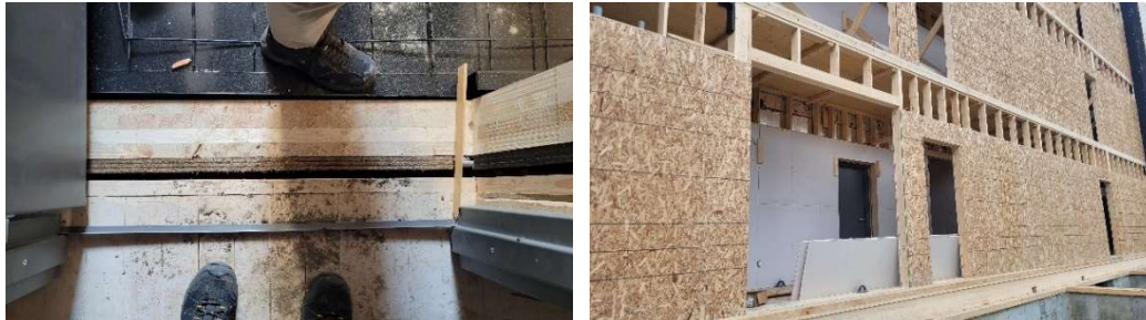
Jonctions intérieures et installation de corridors
