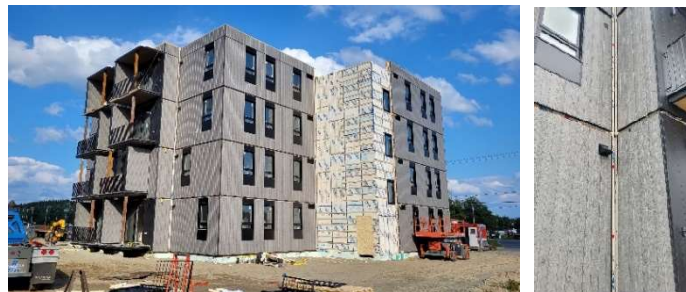
Bâtiment érigé et jonctions extérieures
