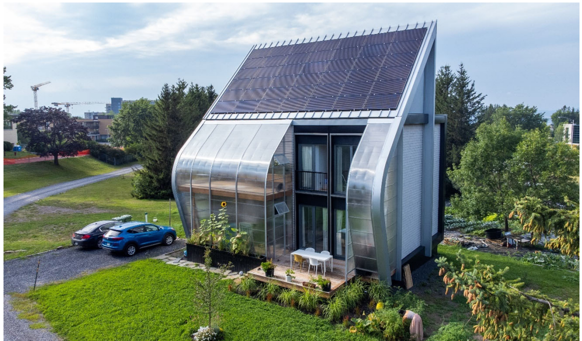
Figure 1 : Vue générale du Laboratoire vivant (été 2021)
