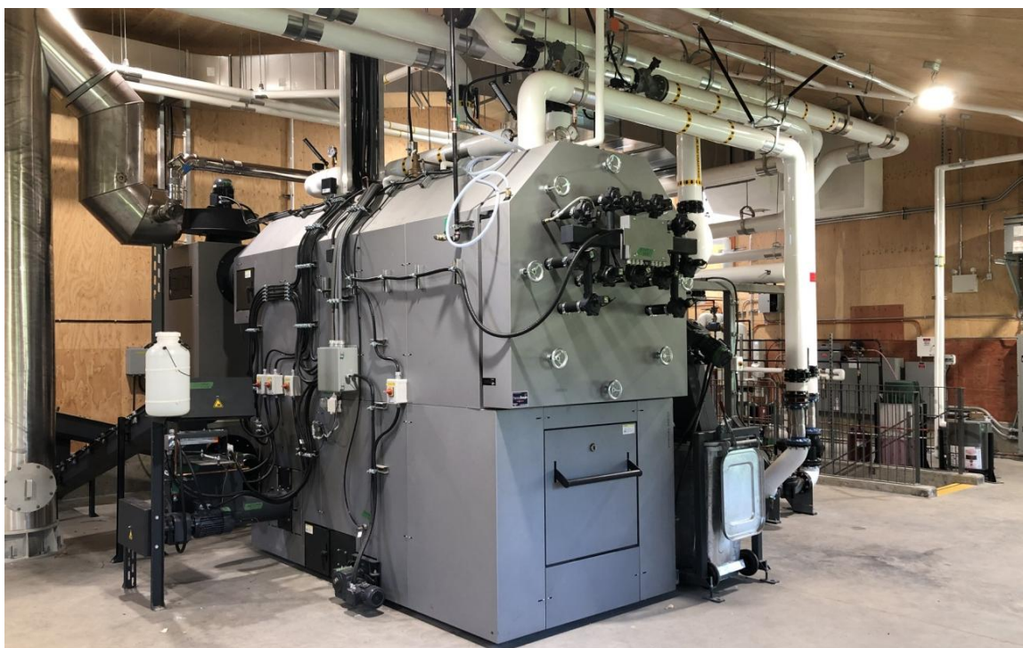
Figure 4 : Vue intérieure du bâtiment
