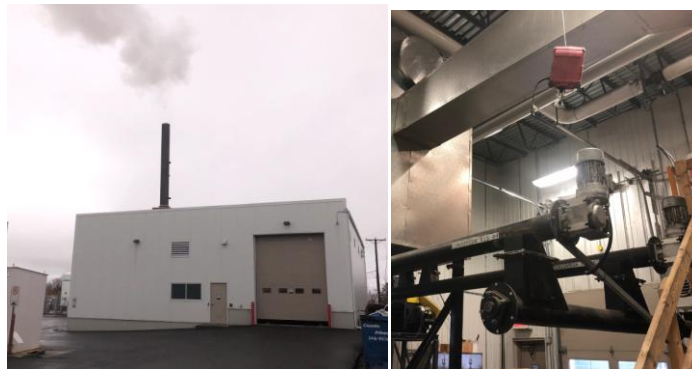
Figure 6 : Centrale de chauffage à la biomasse au CIUSSS de Montmagny : exemple d'un bâtiment type à ossature métallique s'apparentant au scénario de référence retenue.
