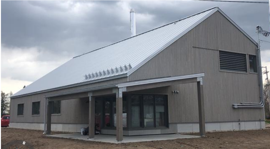
Figure 1 : Vue extérieure de la centrale d'énergie à la biomasse
