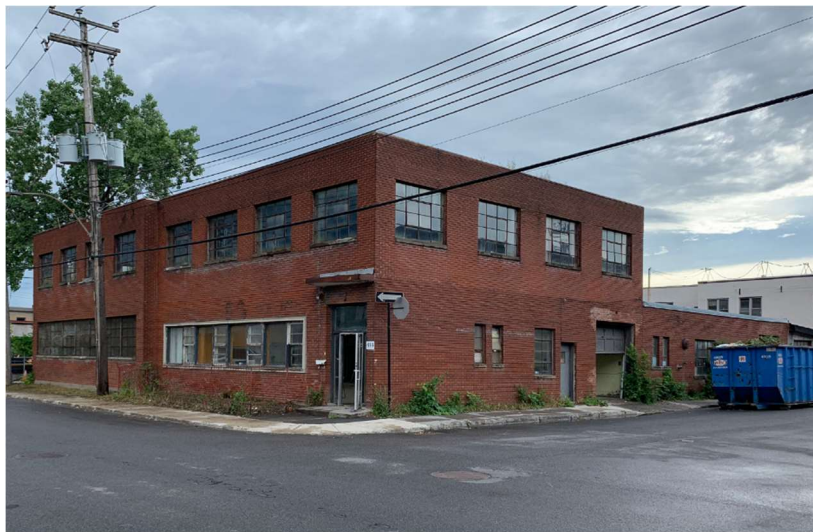
Figure : Bâtiment existant avant la transformation
