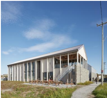
Vue d'ensemble du bâtiment principal montrant les colonnes extérieures
