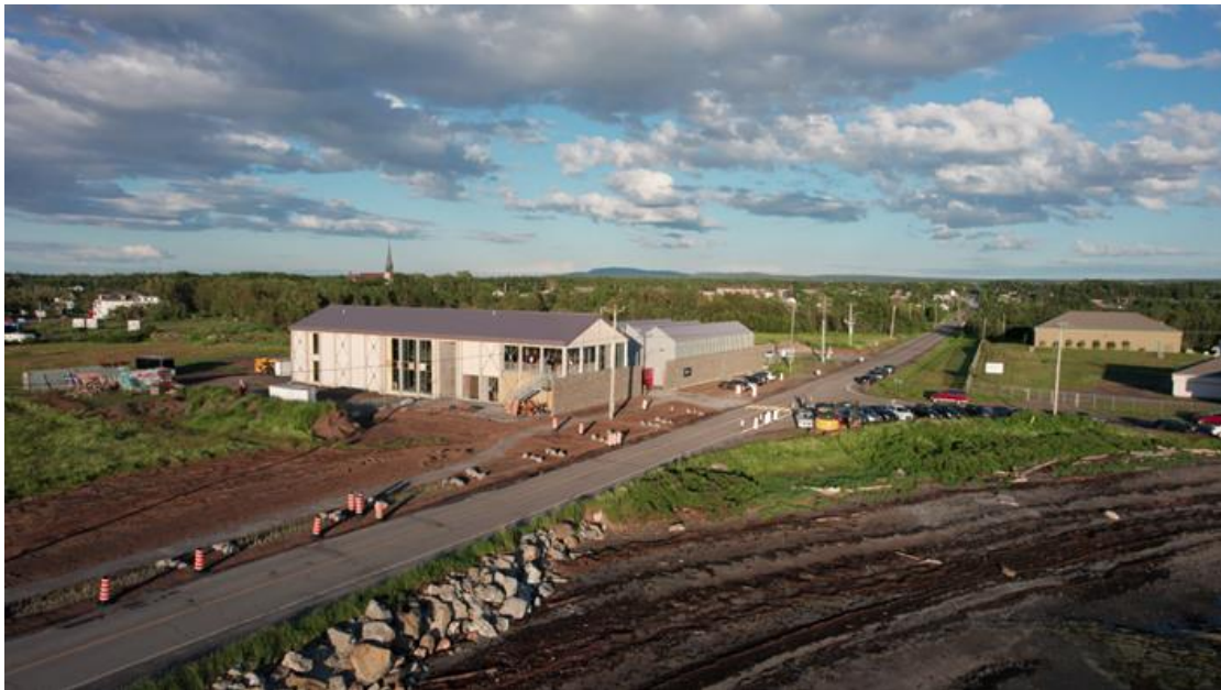
Figure 1 – Le chantier du projet de la Distillerie du St. Laurent
