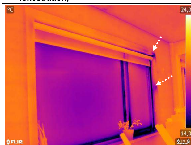
T-108: ( \Delta P -) Infiltration d'air au périmètre de la fenestration;
