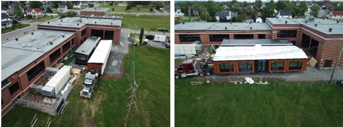
Figure 4 : Vue aérienne de l'installation des modules de salle de classe de l'École Riverside.
