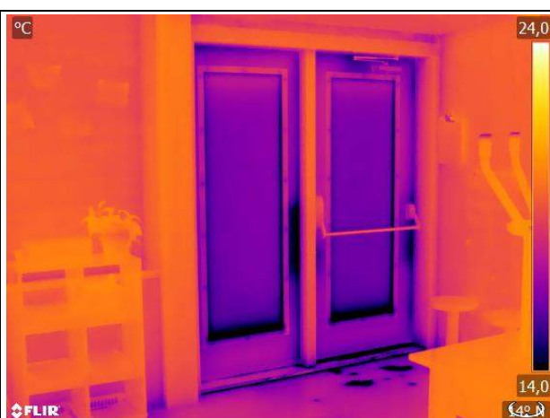
T-111: ( \Delta P +) Comparatif en pression positive; L'eau présente au seuil et sur le plancher ne représente pas une anomalie thermique
