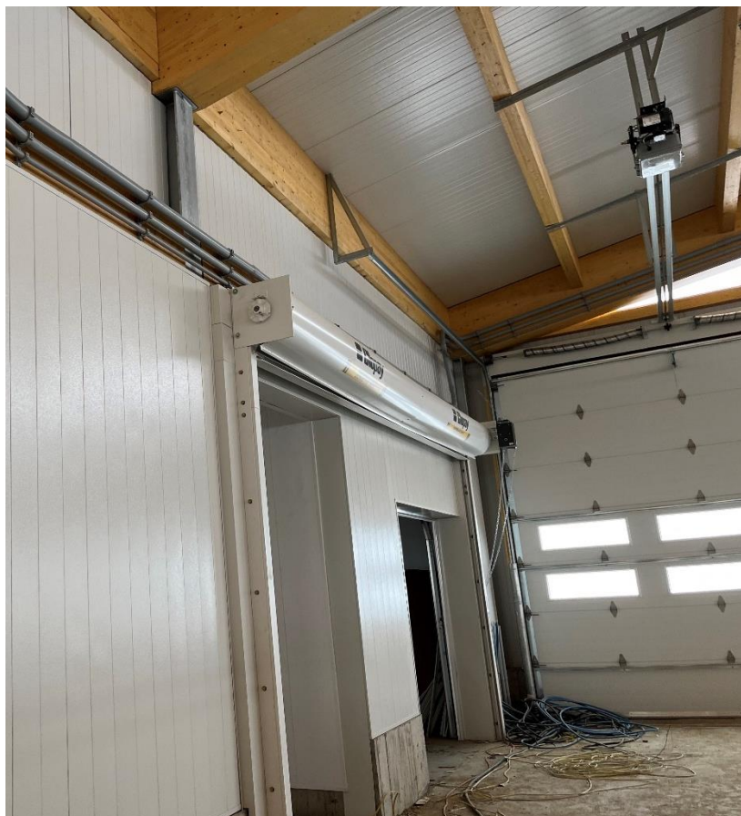
Figure 2 – Mur coupe-feu avec porte déroulante
