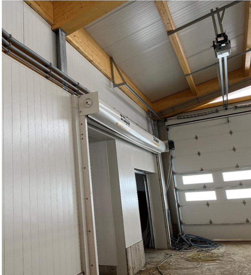
Figure 2 – Mur coupe-feu avec porte déroulante
