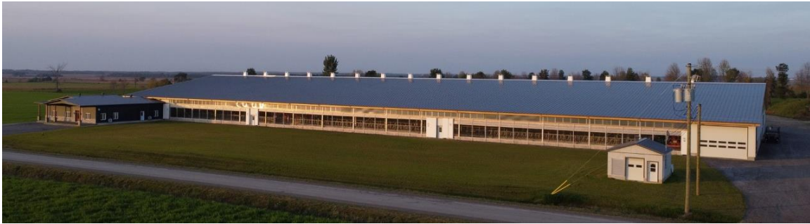
Figure 9 – Vue extérieure du bâtiment
