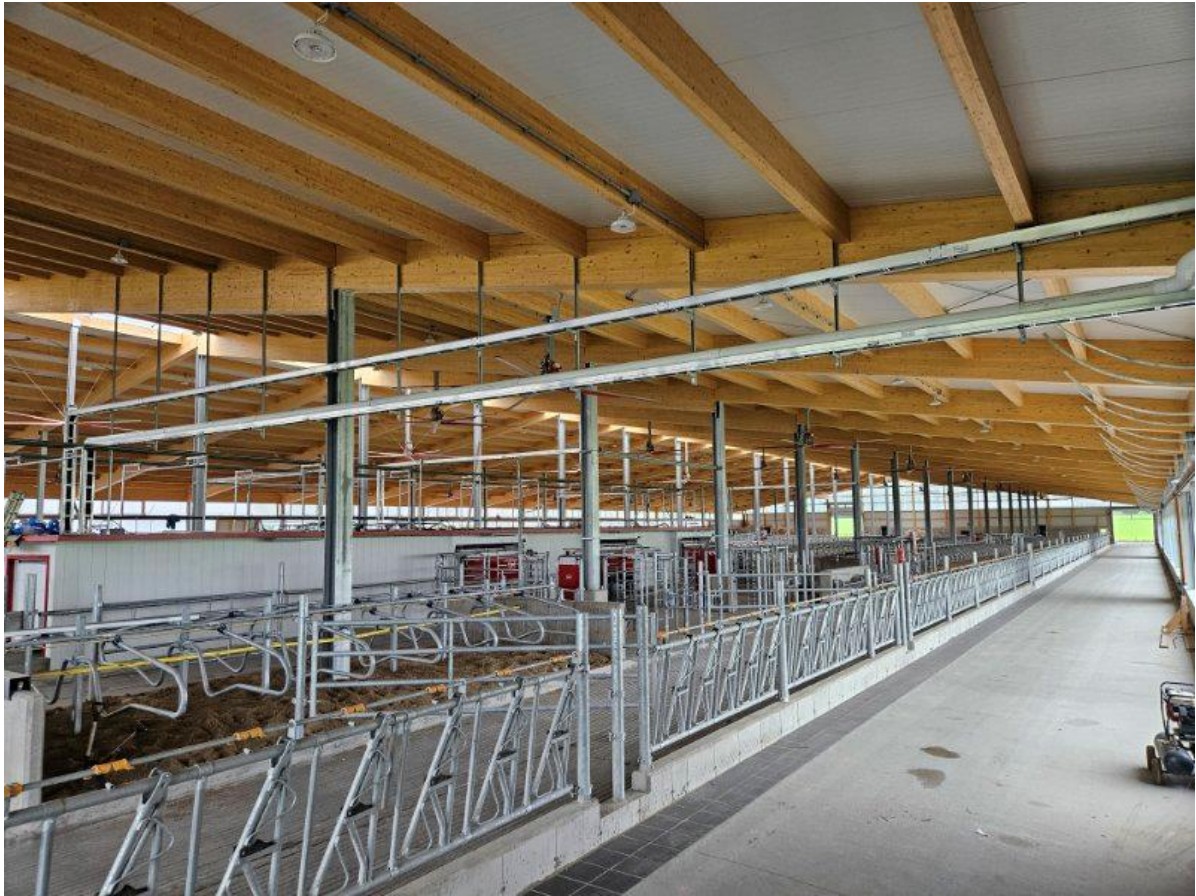
Figure 3 – Assemblage du panneau PMI sur la structure en bois massif
