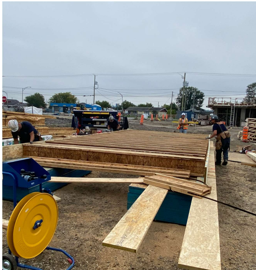
Construction des planchers in-situ au niveau du sol
