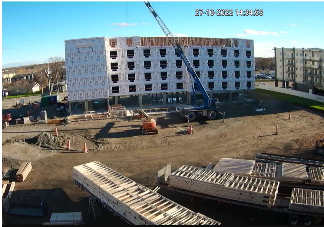
Érection de la structure de l'hôtel 6 e niveau
