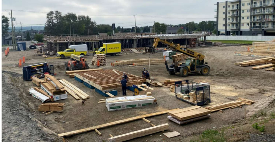
Construction des planchers in-situ au niveau du sol
