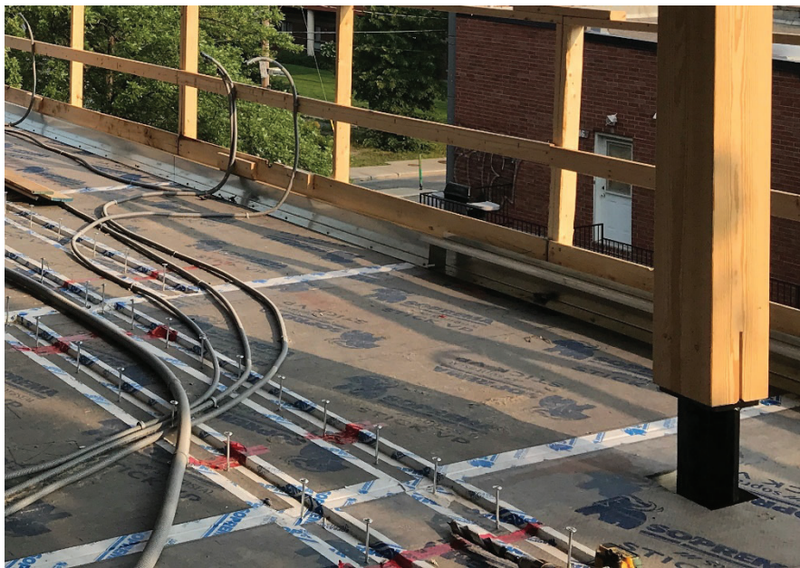
Figure 4 : Dalle de NLVL et vis, avant coulage de la dalle de béton
