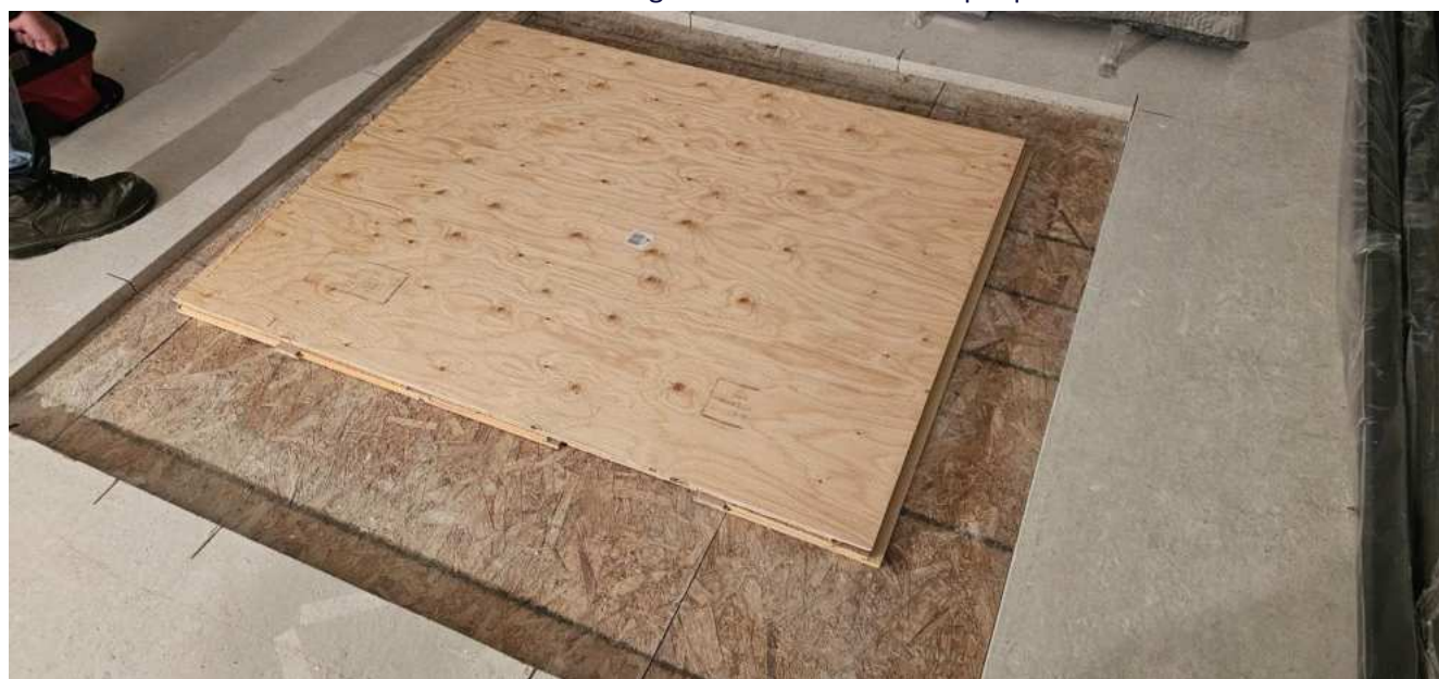
Photo 3 : Assemblage Sonomax 25 + Contreplaqué
