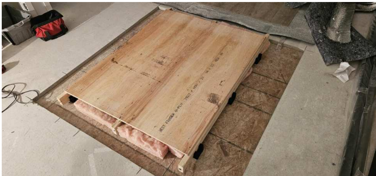
Photo 9 : Assemblage système à lambourdes Cradle
