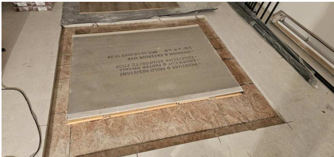
Photo 4 : Assemblage Sonomax 25 + Panneau ciment
