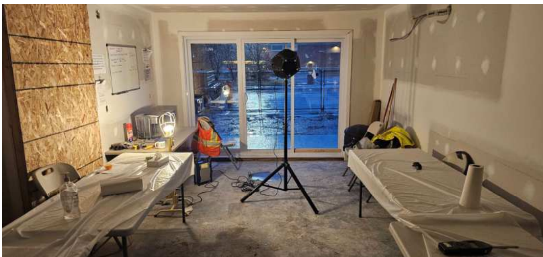
Photo 3 : Mesure de la réverbération dans l'unité 102
