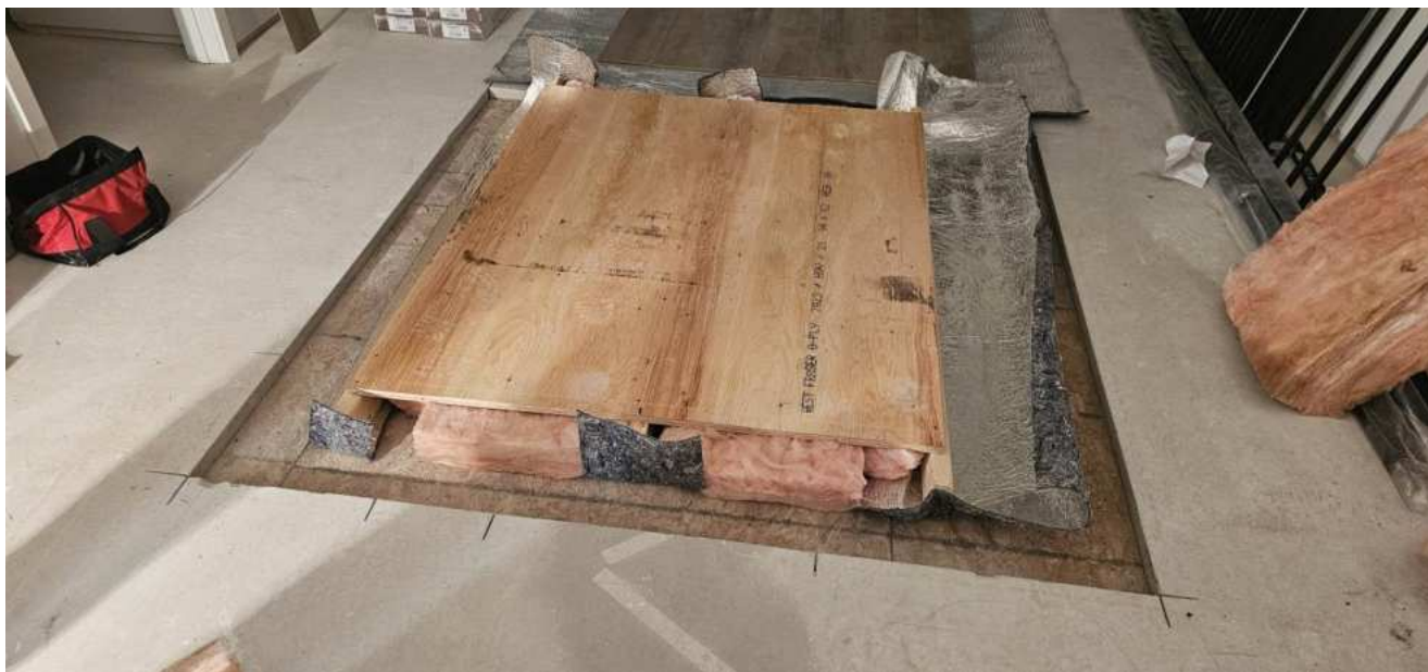
Photo 8 : Assemblage système à lambourdes commun
