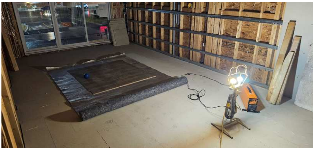
Photo 5 : Assemblage de plancher dans l'unité 202.
