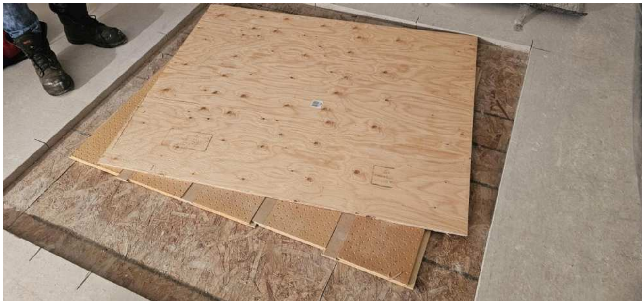
Photo 2 : Assemblage Sonomax 25 + Contreplaqué
