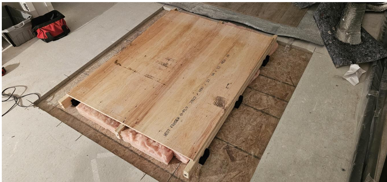
Photo 9 : Assemblage système à lambourdes Cradle
