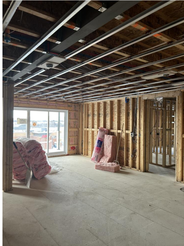
Photos de la pose de la structure du plancher et du Fermacell
