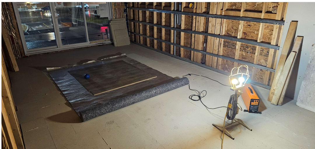
Photo 5 : Assemblage de plancher dans l'unité 202.
