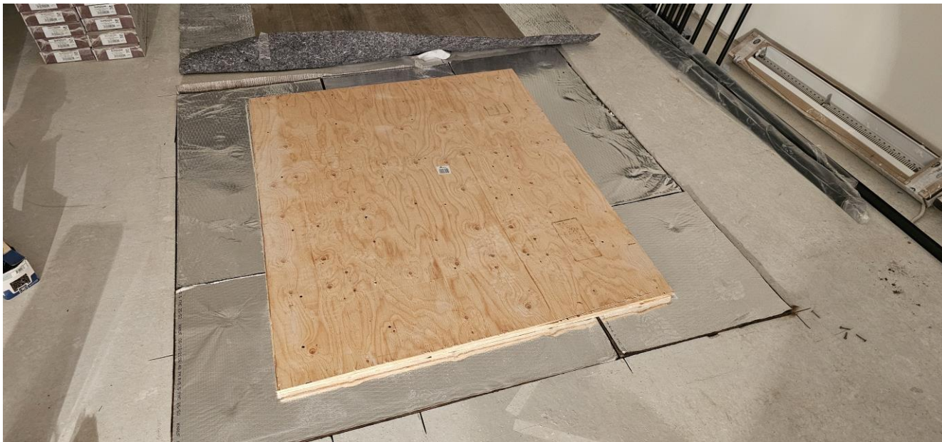
Photo 6 : Assemblage AcoustiTECH SOFIX
