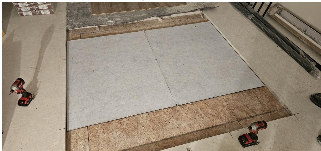
Photo 5 : Assemblage Soprema Acoustiboard
