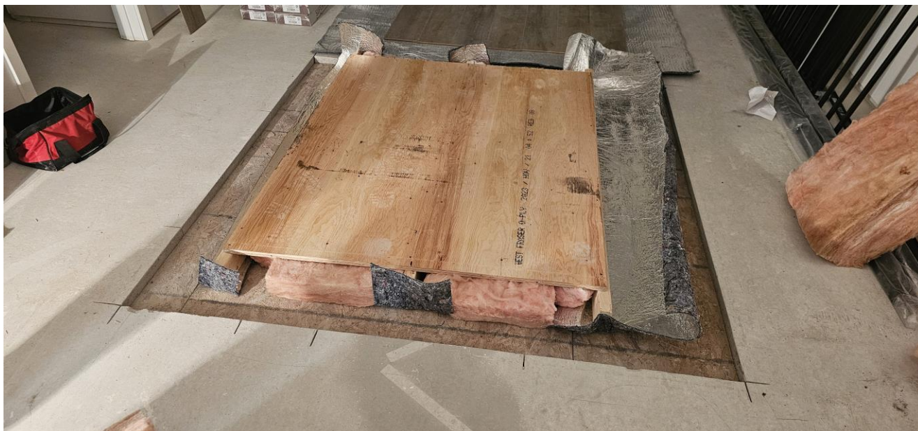
Photo 8 : Assemblage système à lambourdes commun
