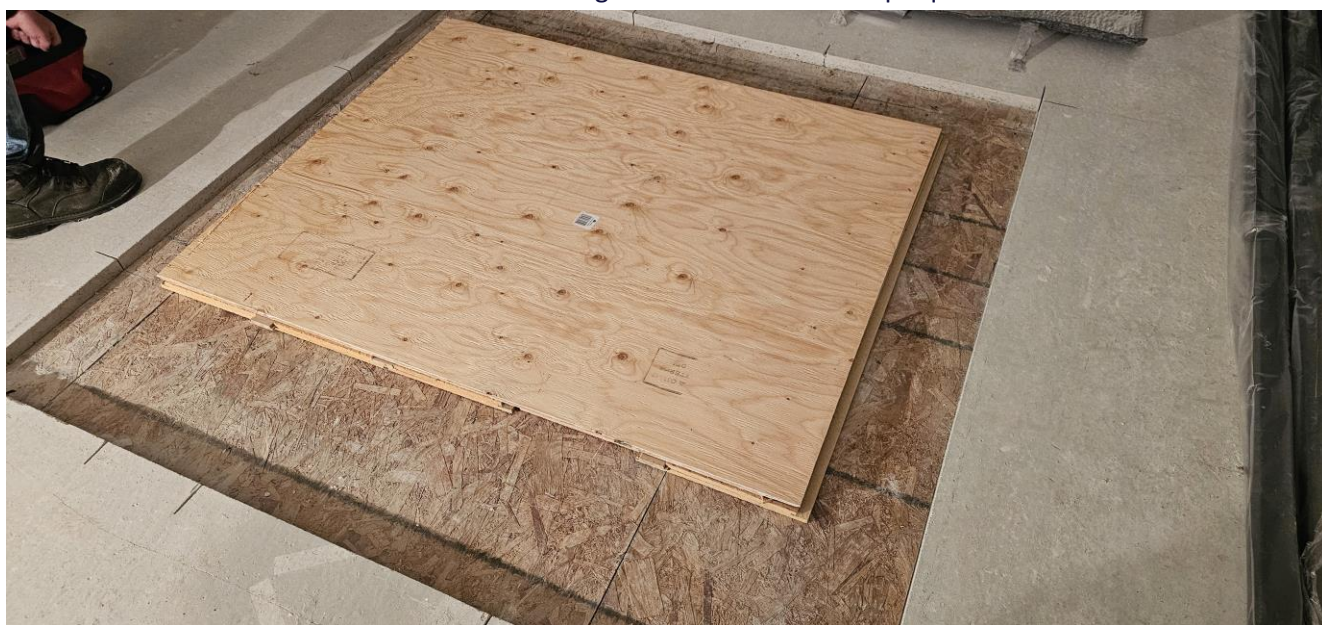
Photo 3 : Assemblage Sonomax 25 + Contreplaqué
