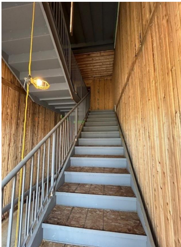
Photo cage d'escalier en NLT
