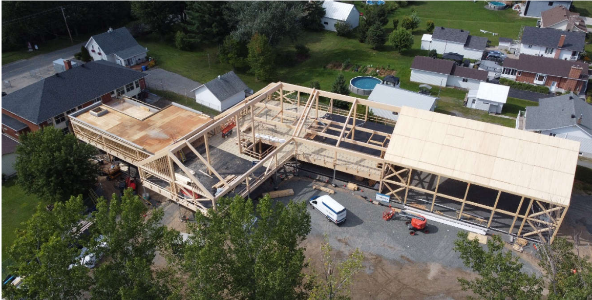
Figure 9 : Vue aérienne de la charpente en bois massif
