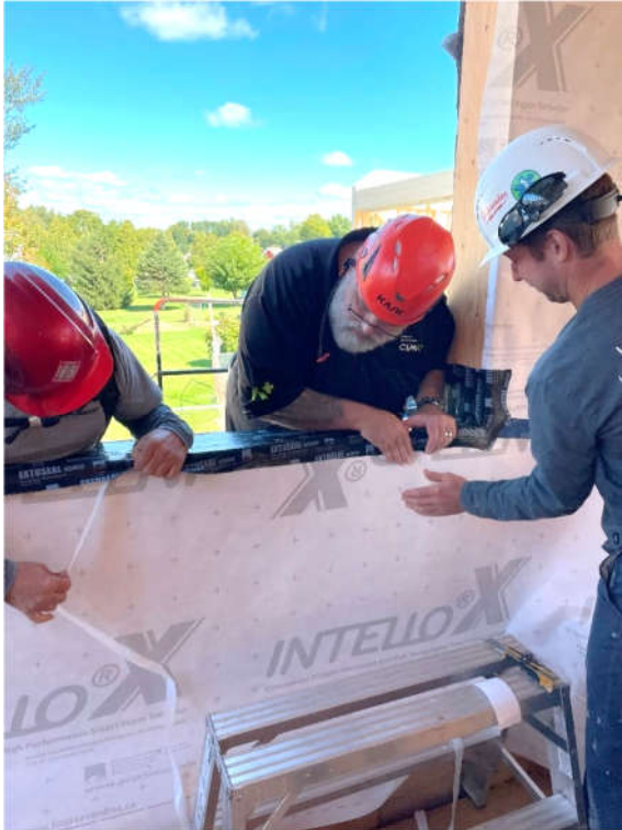
Figure 13 : Démonstration – installation de la membrane de raccordement avec le pare-vapeur
