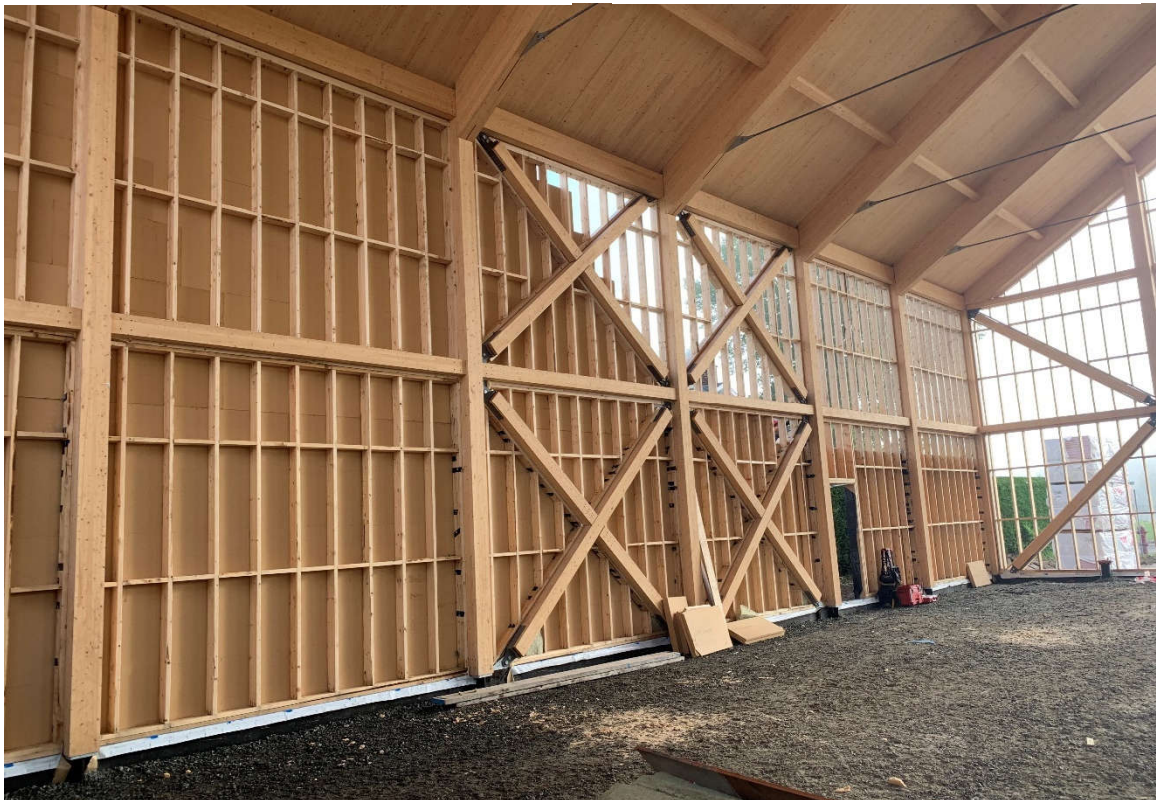
Figure 11 : Vue de l'intérieur du gymnase – installation des panneaux Multitherm en cours
