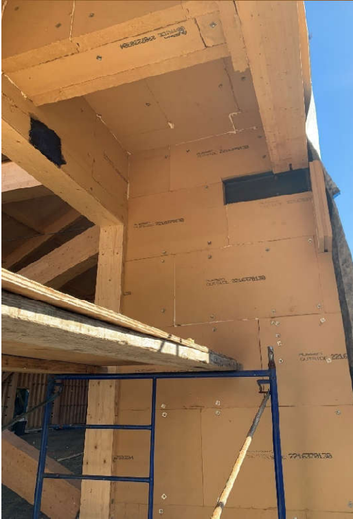
Figure 15 : Installation des panneaux Multitherm dans le soffite
