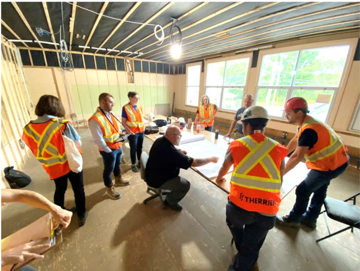
Figure 10 : Réunion de chantier avec Enveloppe au cube en vue de la démonstration de l'installation des composants d'enveloppe
