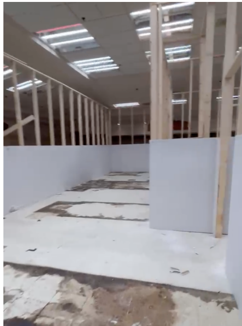
Figure 5 : Essai en chantier de division intérieur des murs de bois
