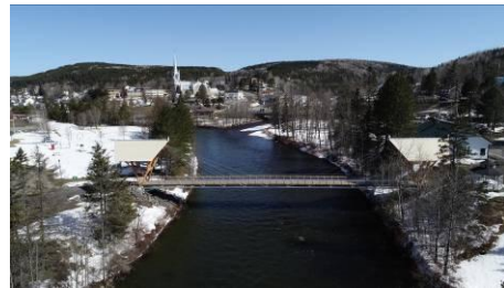
Figure 3: Vue aérienne de la nouvelle passerelle
