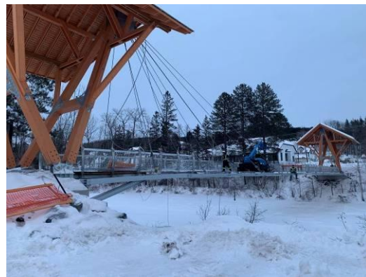
Figure 26: Travaux de montage
