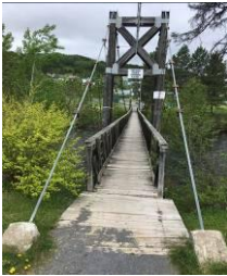
Figure 2: Entrée sud de l'ancienne passerelle
