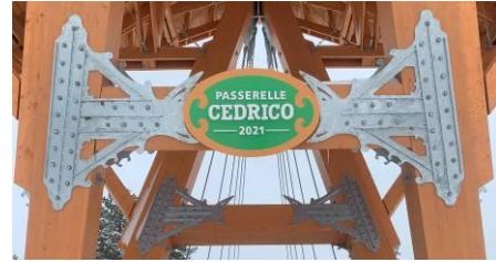
Figure 5: Détail des connecteurs d'acier
