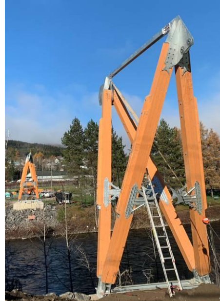
Figure 27: Montage des pylônes en A
