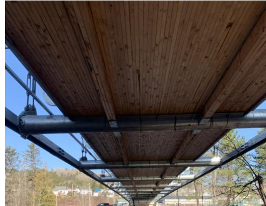
Figure 24: Dessous du tablier en bois
