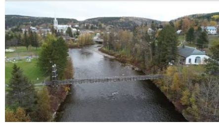
Figure 1 Vue aérienne de l'ancienne passerelle
