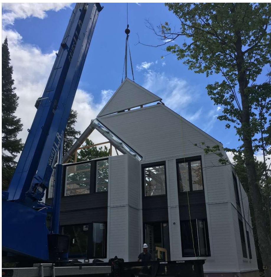
Figure 1 - Projet SOKIO en construction
