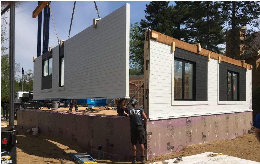
Figure 2 - Les murs totalement préfabriqués du projet SOKIO
