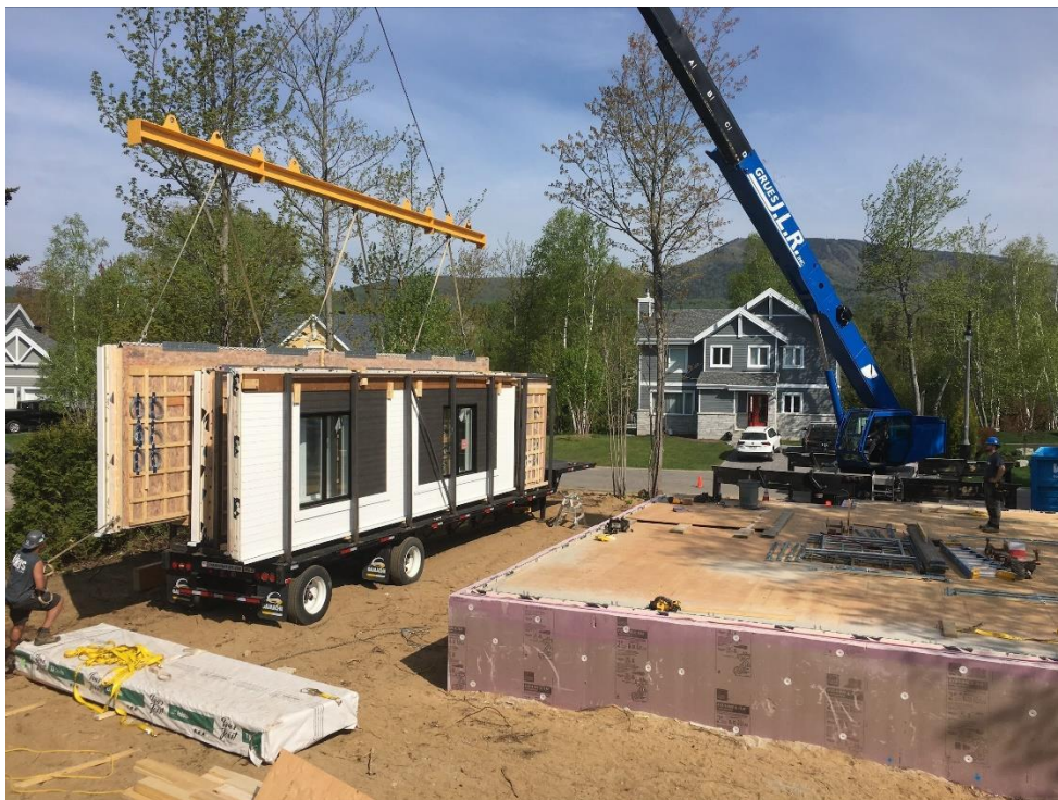
Figure 4 - Système de levage et de transport des murs totalement préfabriqués
