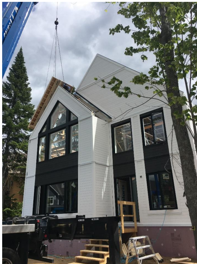
Figure 1 – Le chantier du projet SOKIO
