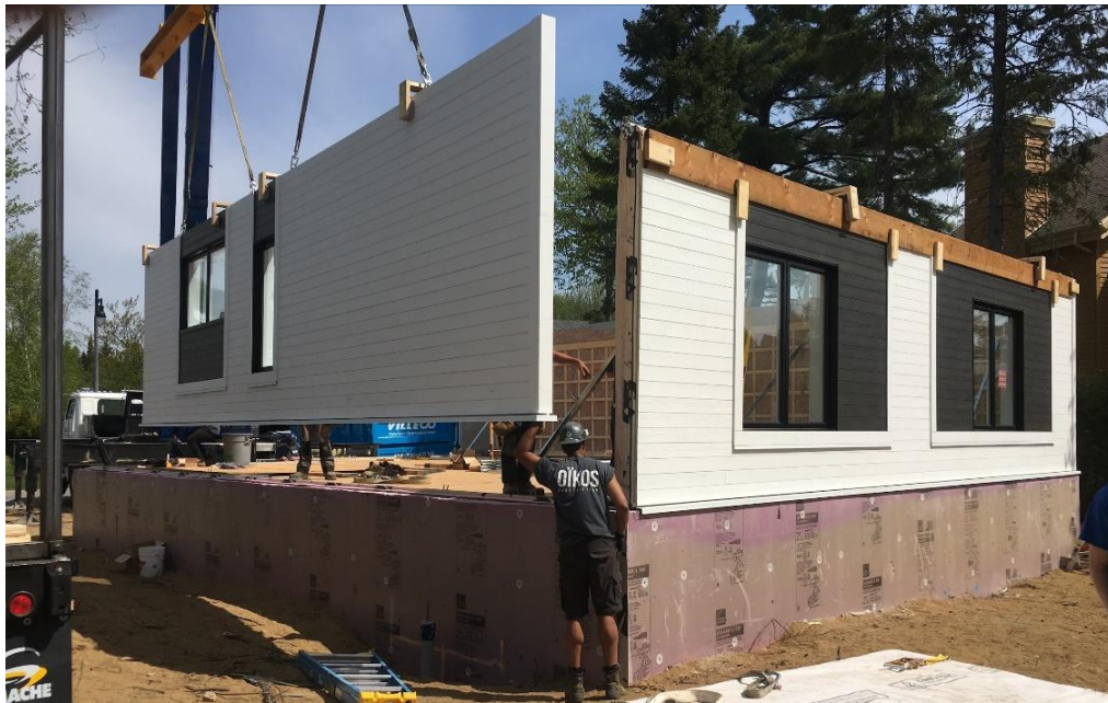
Figure 2 - Les murs totalement préfabriqués du projet SOKIO
