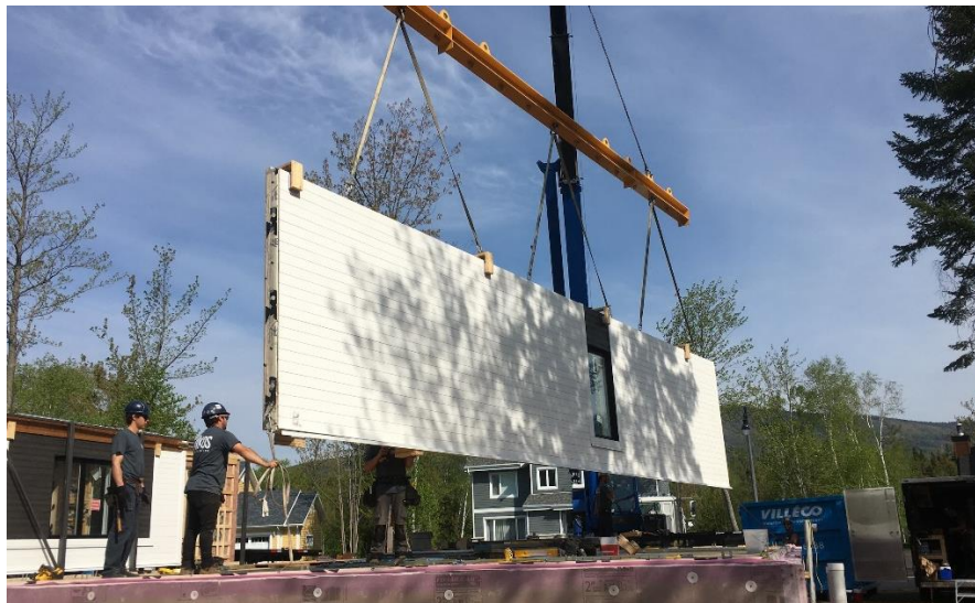
Figure 10 - Levage du premier mur de 12,5 mètres du projet SOKIO
