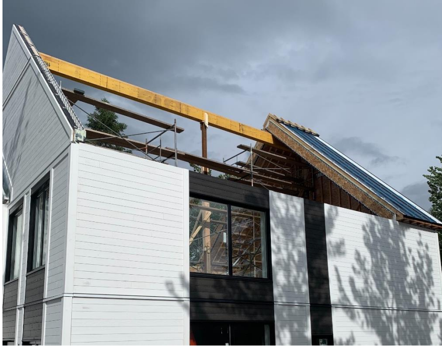
Figure 3 – Un des caissons de toiture totalement préfabriqués du projet SOKIO
