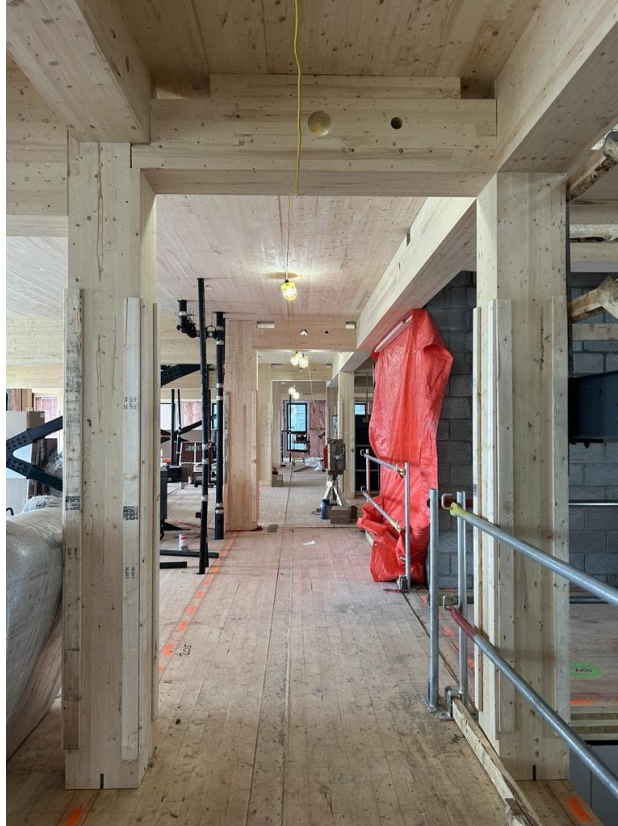
Figure 23 – Protection des coins des colonnes au chantier
