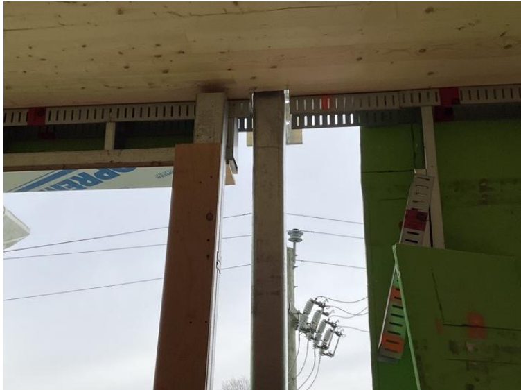
Figure 17 – HSS imbriqué aux panneaux de CLT
