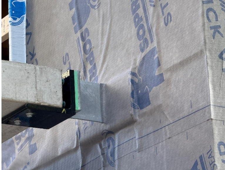
Figure 18 – Connecteur de balcon avec bris thermique Fabreeka en vert
