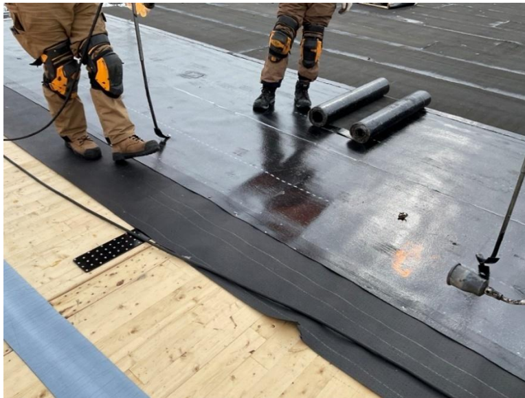
Figure 21 – Mise en œuvre du système de pare-vapeur sur la toiture
