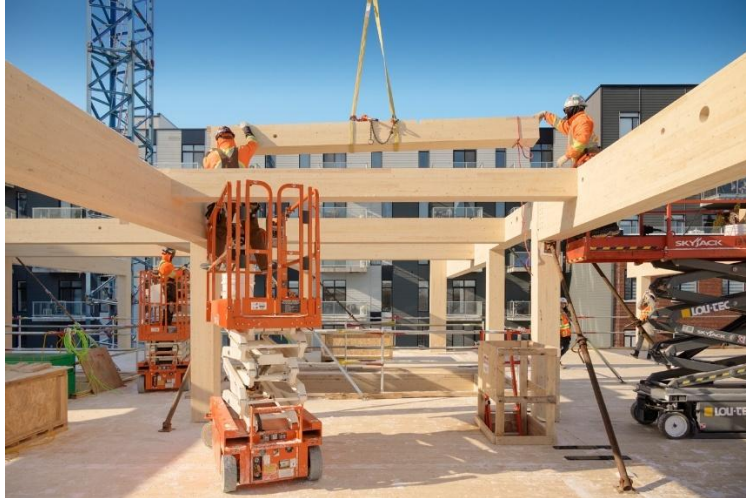
Figure 3 – Montage de la structure de bois et d'acier par Tergos
