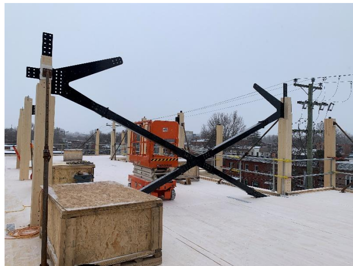
Figure 4 – Contreventement en acier en cours d'installation
