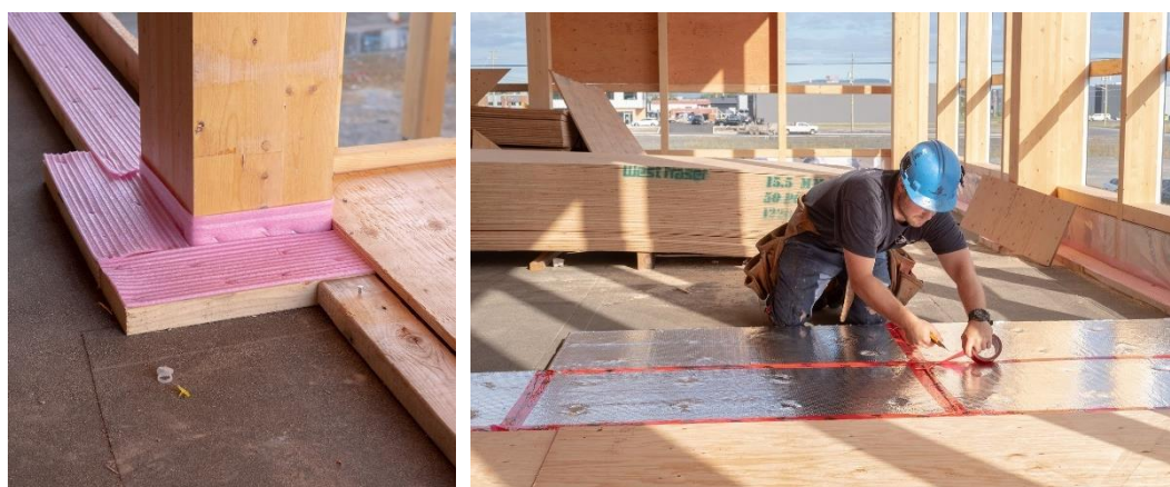
Figure 9– Installation du système AcoustiTECH SOFIX au chantier. Photo des bandes d'étanchéité en périphérie et photo d'installation des modules acoustiques joints et scellés. ©Atelier Guy architectes
