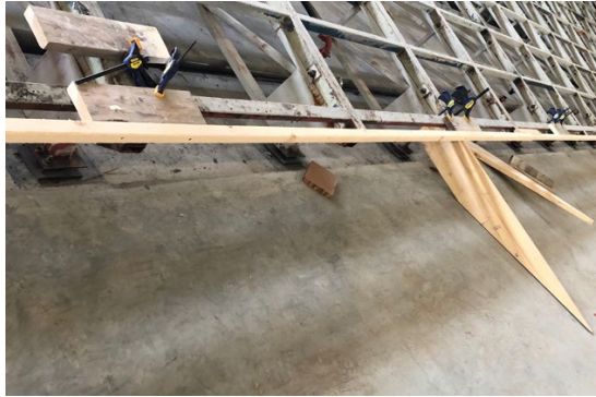
Figure 17-18 : Ajout de fond de clouage pour la piste
