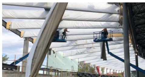
Figure 11-12 : Installation des poutrelles de bois (suite)
