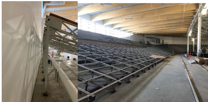
Figure 14-15: Installation de la structure de la piste en acier
