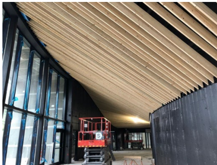
Figure 20 : installation et ancrage du plafond structural de bois dans le hall
