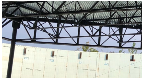
Figure 8 : Installation des ancrages prête à recevoir les poutrelles de bois, dans le mur de coffrage isolant
