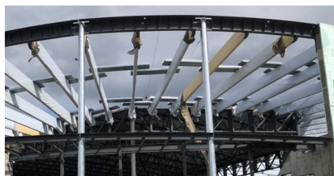
Figure 11-12 : Installation des poutrelles de bois (suite)
