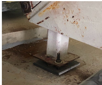
Figure 16 : Fixation de la structure d'acier au plancher de béton
