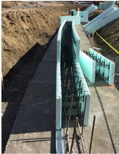
Figure 6 : Arrimage du mur de coffrage isolant sur le mur de fondation
