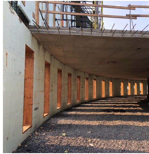
Figure 7 : Arrimage de la dalle de béton de la mezzanine au mur de coffrage isolant
