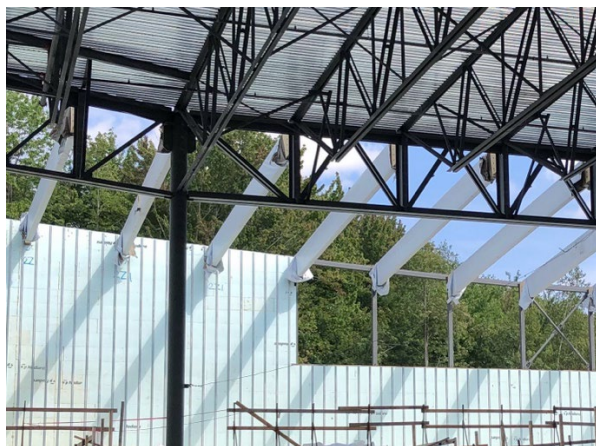
Figure 9-10 : Installation des poutrelles de bois
