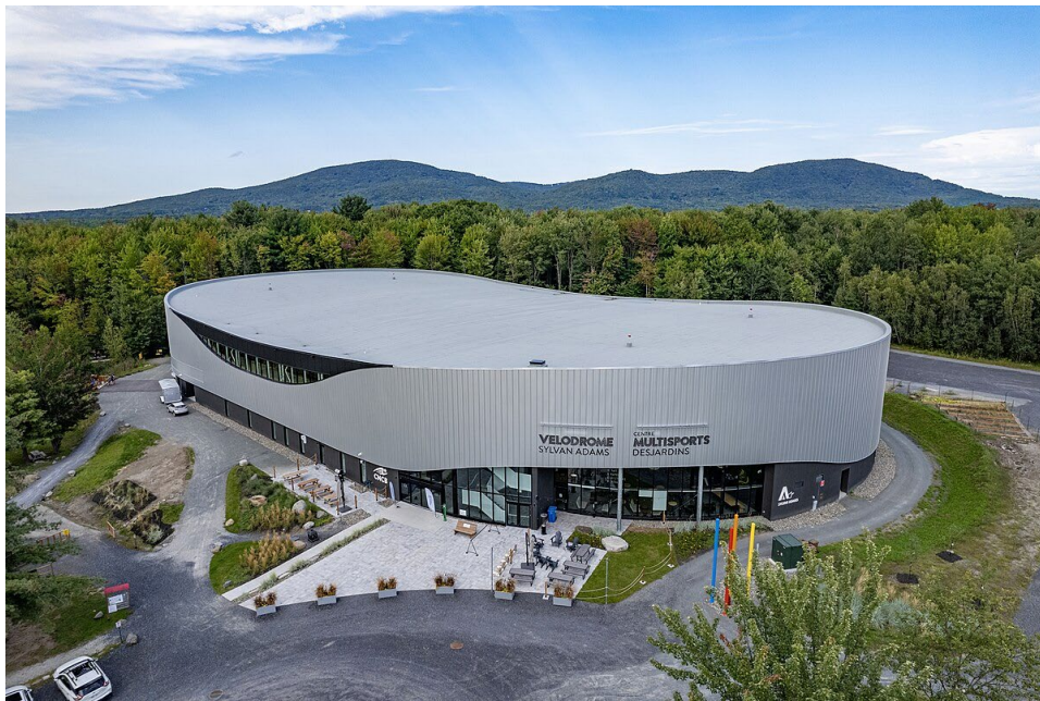
Figure 1 : Vue extérieure du nouveau Vélodrome
