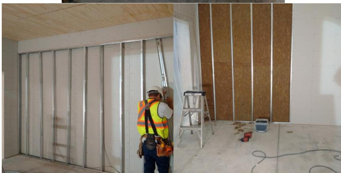
Figure 9. Composantes du mur mitoyen dans le compartiment résistant au feu
