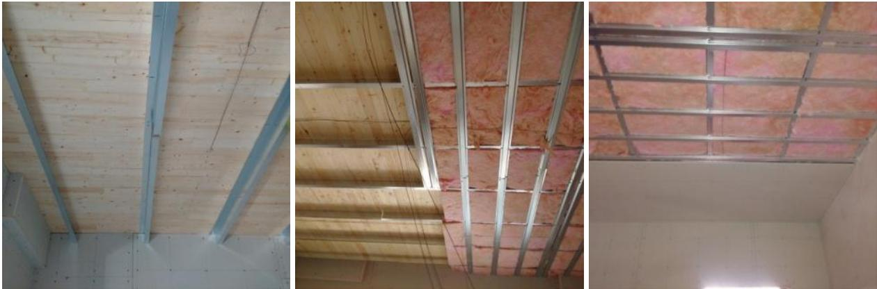
**Figure 10. Composantes de l'élément plafond dans le compartiment résistant au feu**
